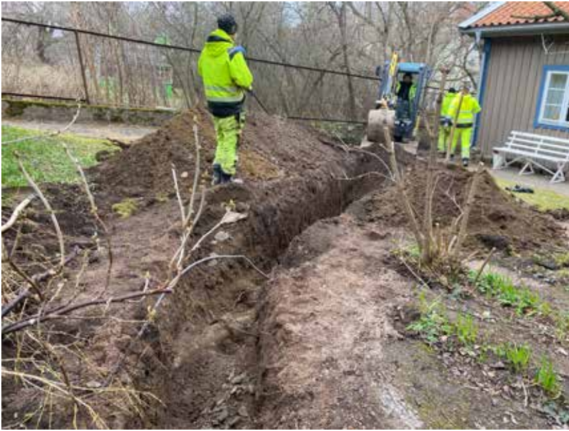
Figur 5. Schakt 3 grävs. Foto: Kristina Jansson. Från öster.
