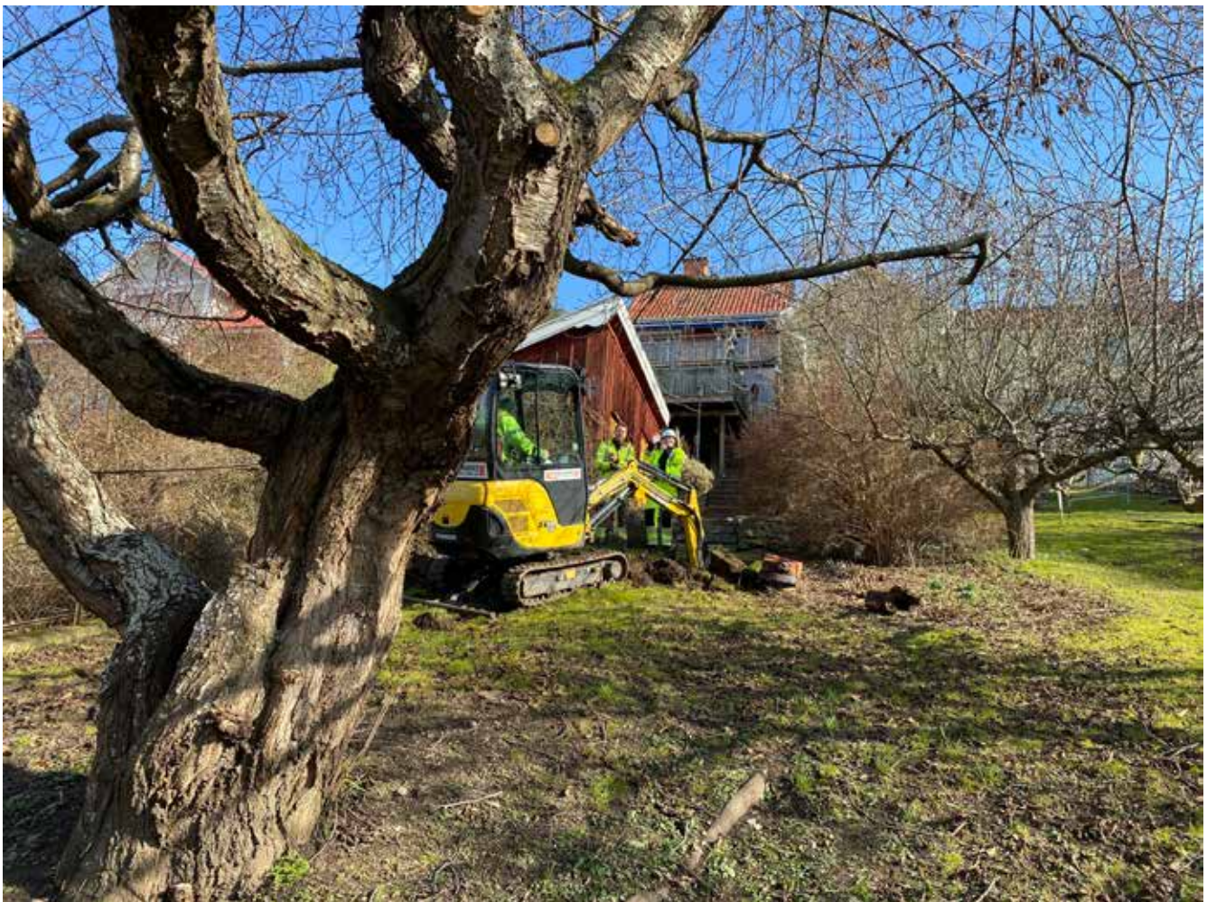
Figur 3. Grävningen av schakt 2 har påbörjats. Foto från väster.
