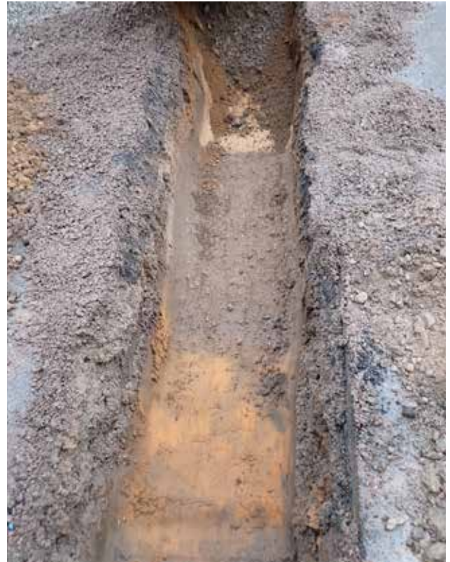
Figur 6. Olikfärgade moderna fyllningar i botten av schakt 2. Foto från öst.
