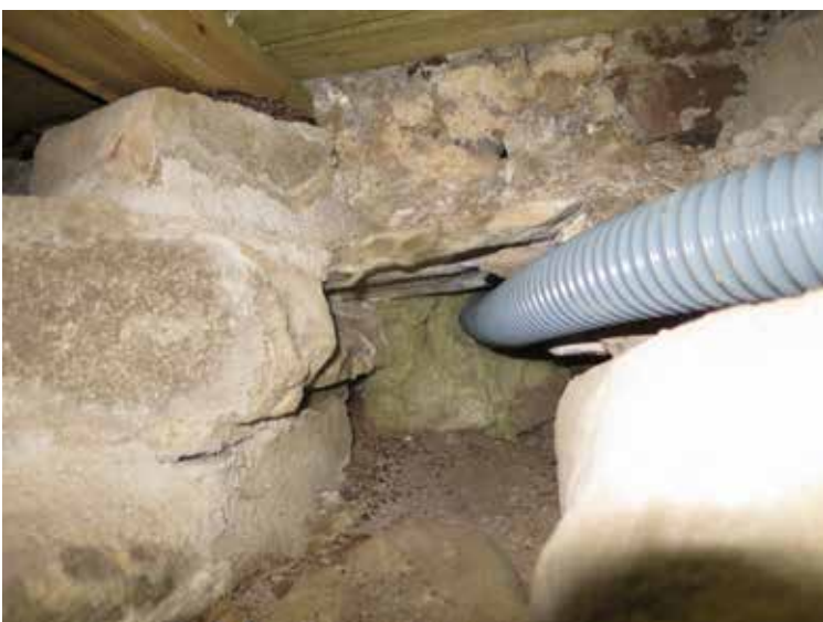
Ovan: Det nya aggregatet blev inte synligt från golvluckan i sakristian. Till vänster: Utlufsörret vilket drogs igenom befintlig genomföring i östra grundmuren.
