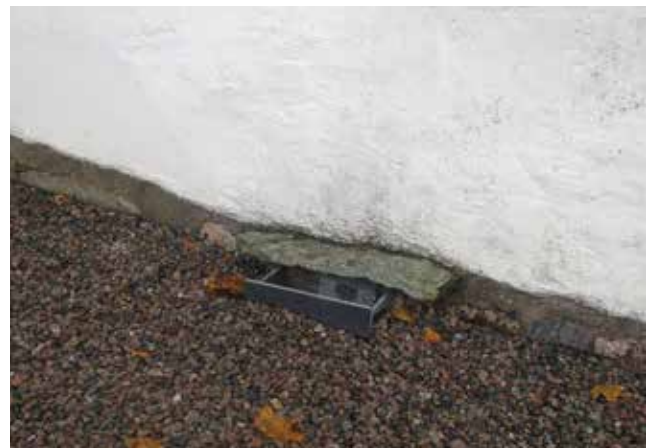
Till vänster: Ventilöppning åt öster på sakristian med nytt frånluftsdon (vid slutbesiktningen). Ovan: Mittersta ventilöppningen åt norr på långhuset efter igensättning och montage av nytt utluftsdon (se även bilaga 2).
