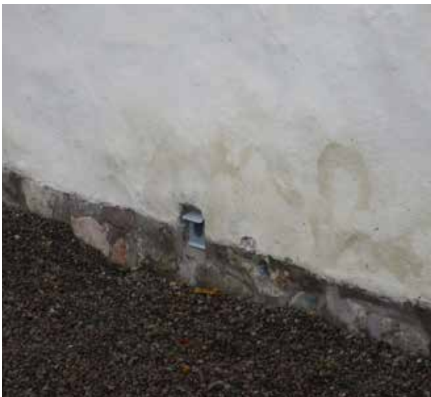
Till vänster: Ventilöppning åt öster på sakristian med nytt frånluftsdon (vid slutbesiktningen). Ovan: Mittersta ventilöppningen åt norr på långhuset efter igensättning och montage av nytt utluftsdon (se även bilaga 2).
