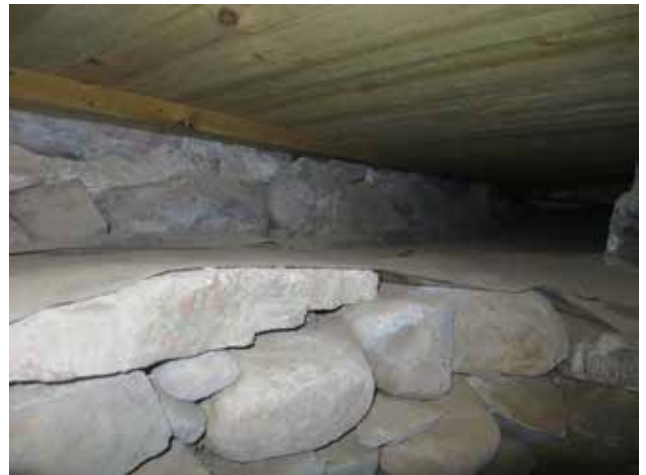
Krypgrunden under sakristina var även den utgrävd på 1970-talet. Här syns utrymmet direkt öster om vinkällaren. På marken låg en plastfilm.
