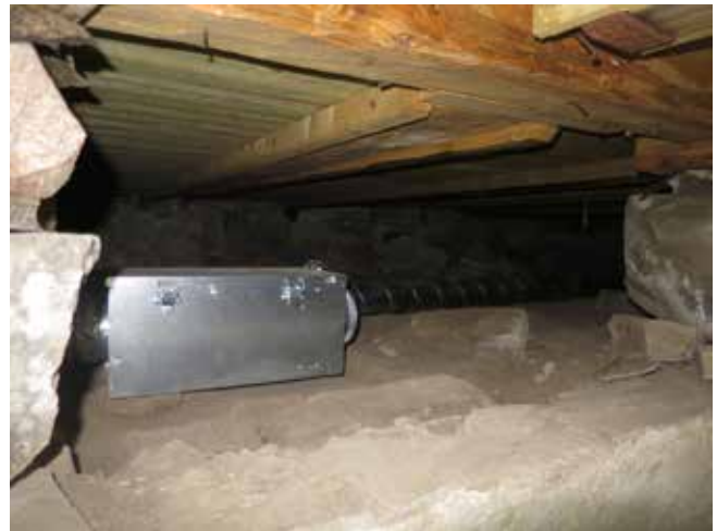
Spiroröret i nordöstra delen av långhusets kryppgrund.
