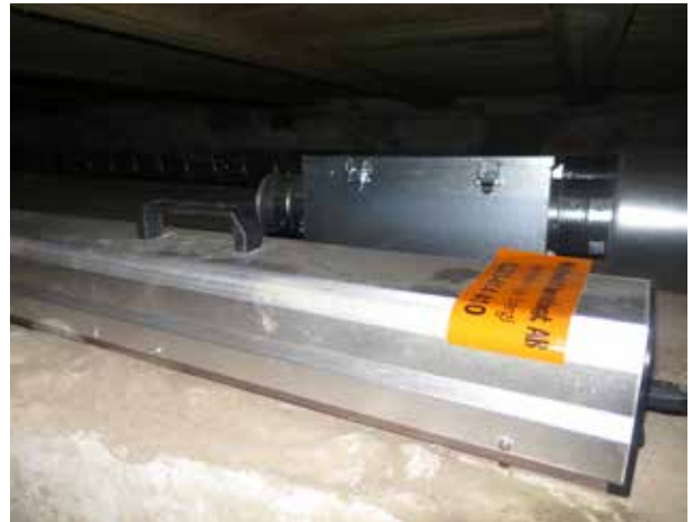
Luftrenare ingick i förslaget men slogs av enligt förslag vid slutbesiktningen. Anledningen var att luftrenaren utsöndrade ozon, en gas som kan vara skadlig för kyrkans värdefulla inredning och föremål.
