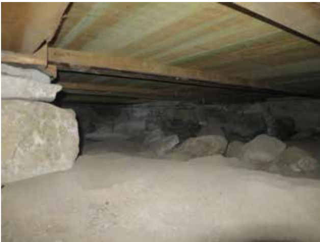
Krypgrunden under långhuset var utgrävd på 1970-talet och de översta jordlagren hade ersatts med sand. Trossbottenpanelen var från samma tid och saknade därmed antikvariska värden.
