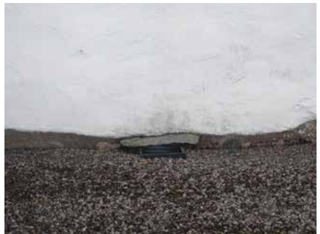
Till vänster: Ventilöppning i sakristians östra fasad före åtgärd. Ovan: Ena ventilöppningen i långhusets norra fasad i mars 2021.
