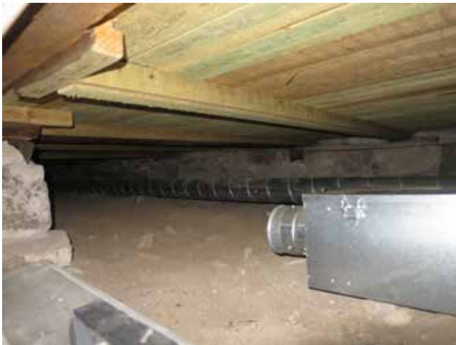
Spiroröret i nordvästra delen av långhusets kryppgrund.
