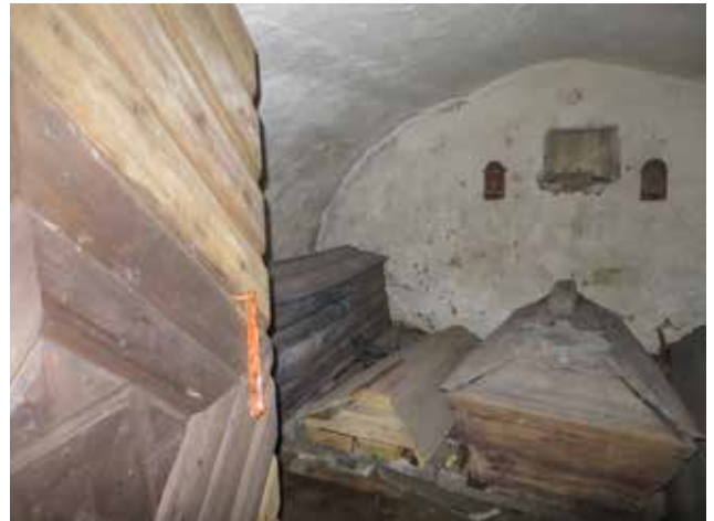
Linnerhielmska gravkammaren under långhusets västra del, vilken indirekt kom att avfuktas genom det nya aggregatet i krypgrunden.
