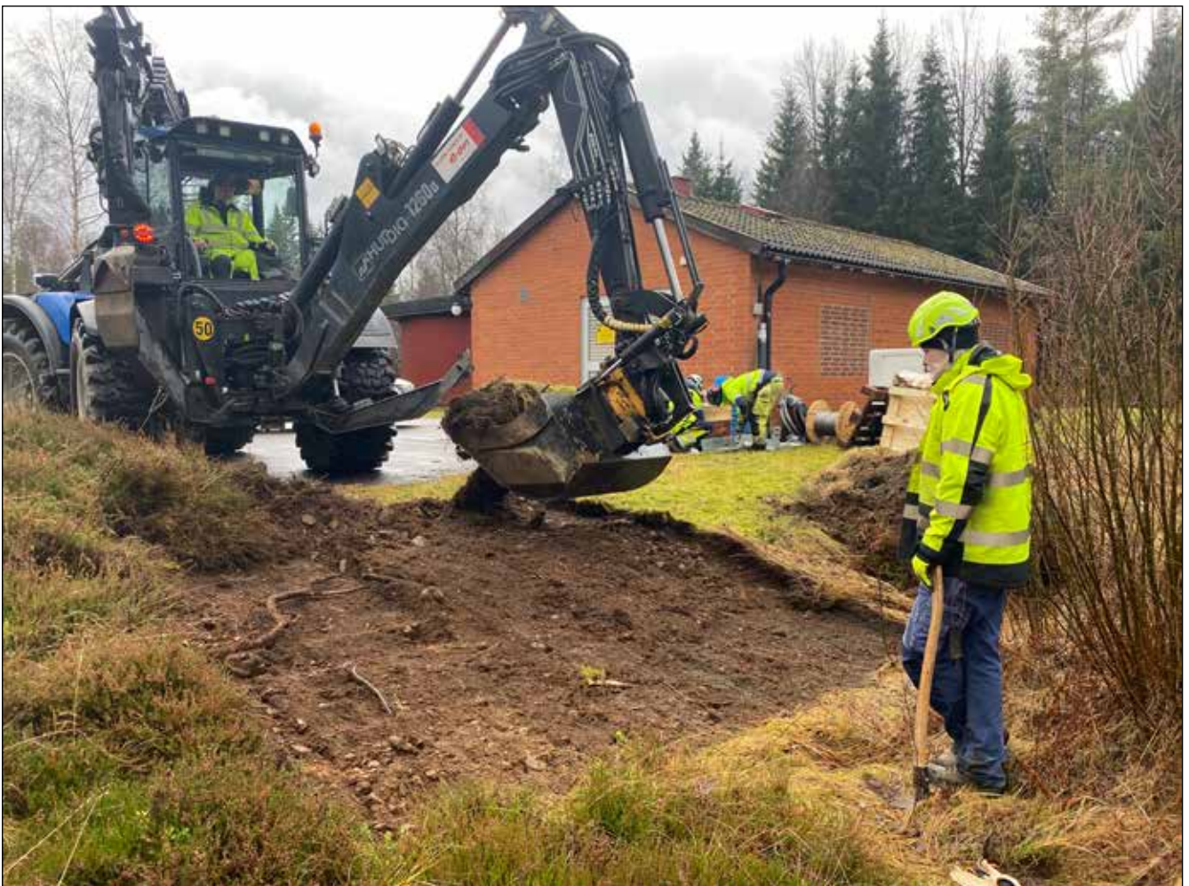
Figur 2. Schaktning för markstation pågår. Foto från norr.
