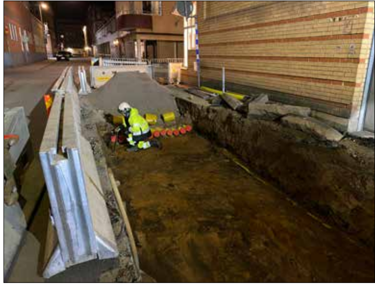
Figur 3. Nattgrävning vid parkeringshuset Per Brahe mellan Brunnsgatan och Nygatan. Foto från söder.
