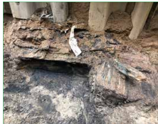
Figur 42. Delar av hörnkonstruktionen, A50, i den östra delen av byggnaden inom tomt 126. Här syns det brunsvarta golvlagret, de längsgående och tvärgående stockarna. Foto från norr.
