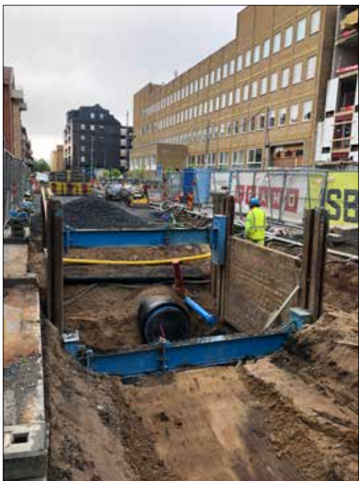
Figur 33 Översikt från korsningen Änkhusgatan/ Slottsgatan med återfylld, nedschaktad och delvis schaktad låda. Nybyggnation på Domstolen 1 ses i den högra delen. Foto från väst.
