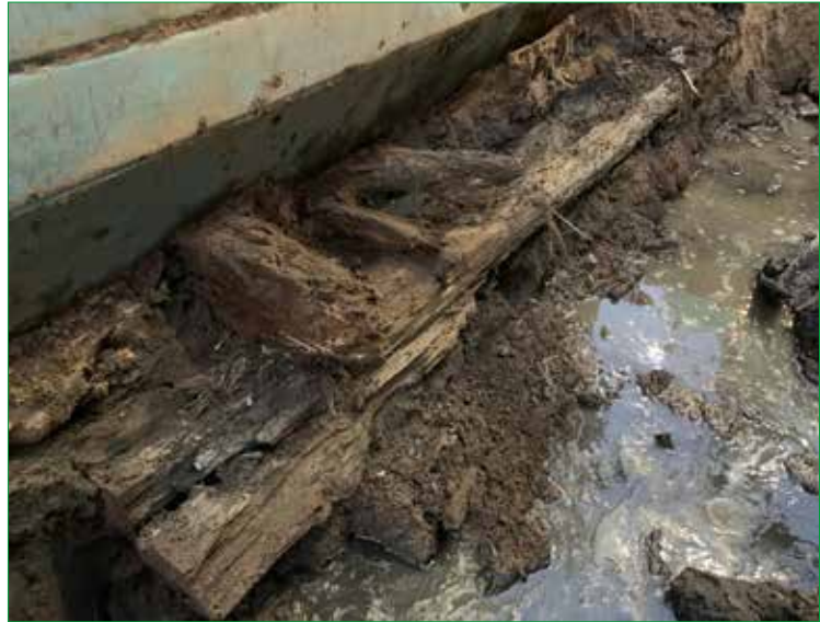
Figur 63. Grundläggning av stockar till byggnaden A68 på tomt 112 under schaktlådan i den södra kanten. Foto från nordöst.
