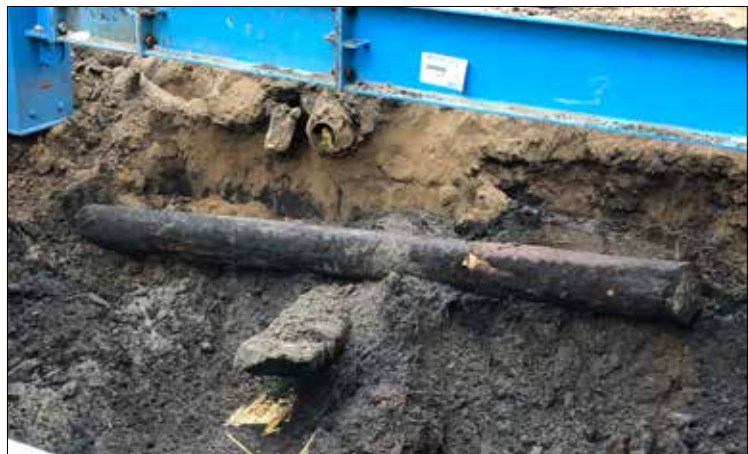
Figur 9. Del av de liggande rustbädden som lagts i två olika riktningar. Det var barkade kraftiga stockar som ibland hade tillhuggna ändar. Foto från öster.
