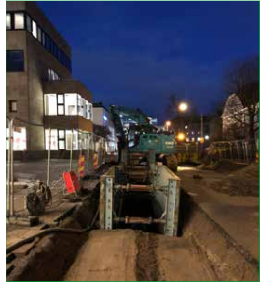
Figur 61. Längs med den västligaste sträckan vid biblioteket och läns museet smalade schaktet av betydligt. Foto från öster.
