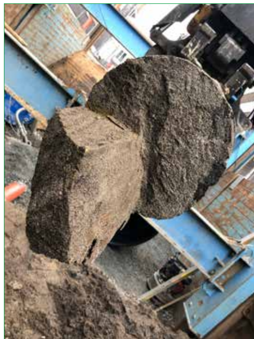
Figur 48. Den tillhuggna grundstocken (A53) som låg längs med byggnaden och hade knuten under hörnstenen i väster.
