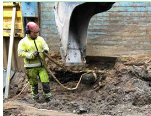
Figur 38. En liggande grundstock, A39, dras fram under schaktlådan för att sågas till dendroprov nummer 20. Foto från norr.
