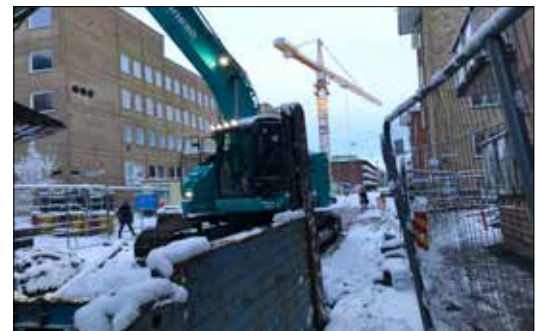
Figur 11. Korsningen Slottsgatan/Änkhusgatan, schaktning i snö. Foto från öster.
