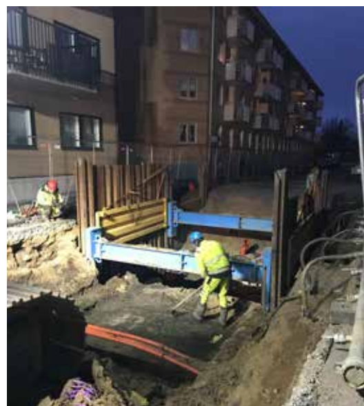
Figur 4 Schaktning vid kvarteret Citadellet en tidig decembermorgon. Återkommande fanns ledningar som försvårade för schaktlådan att tryckas ner och för arkeologen att göra observationer. Foto från sydväst..
