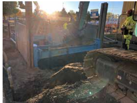
Figur 2. Arbetsbild med två schaktlådor i korsningen Slottsgatan/Tullportsgatan i starten i oktober 2021. Foto från väster.
