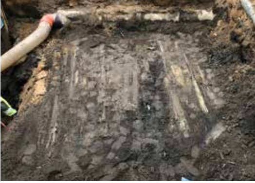
Figur 7. Den övre rustbädden, löpande i nord-sydlig riktning, som utgjort underlag till Slottsgatan. Foto från norr.
