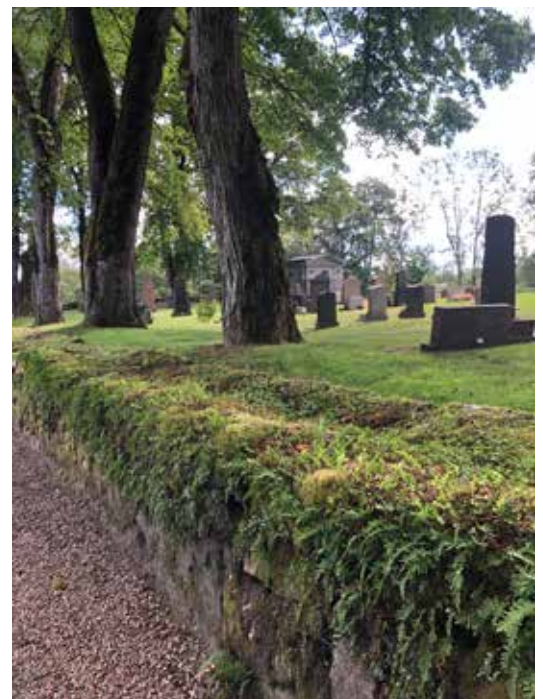
Kyrkogården omges av en mur med otuktade och kilade stenblock.
