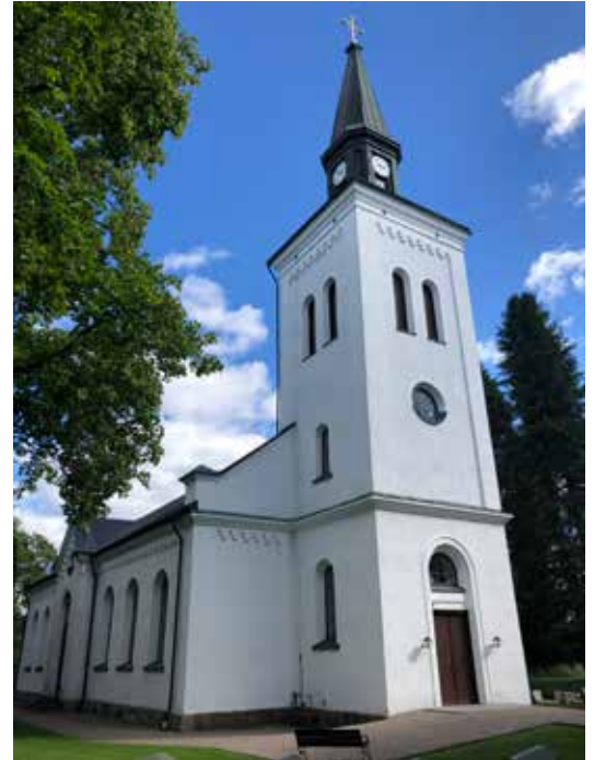
Båraryds kyrka uppfördes 1880 efter ritningar av arkitekt Albert Törnqvist. I samband med att den nya kyrkan uppfördes utvidgades även kyrkogården till dagens storlek.
