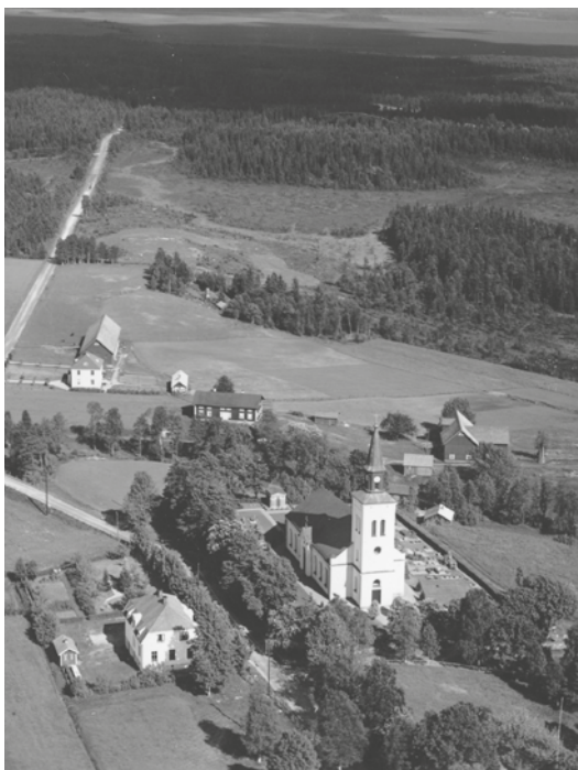
Båraryds kyrka från väster med skolbyggnaden. Den norra delen av kyrkogården har en välväxt trädrad längs landsvägen. Flygfoto, 1939. JLM.
