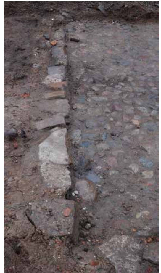
Figur 6. Stenläggningen (A262) och syllstensraden (272) på den södra sidan om denna. Syllstensraden har utgjort grunden till väggen på den byggnad som varit ihopbyggd med portgången. Foto från öster.
