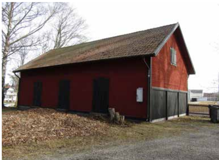
Byggnadens kopplade fönster tillkom sannolikt omkring 1930-talet. Fasadpanelen med sina kilsågade bottenbräder förefaller ha en hög ålder.
