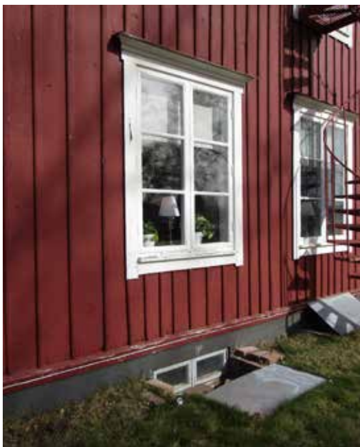
Byggnadens kopplade fönster tillkom sannolikt omkring 1930-talet. Fasadpanelen med sina kilsågade bottenbräder förefaller ha en hög ålder.
