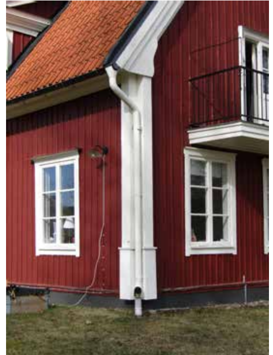
Bostadshusets timrade stomme blir tydlig genom de knutlådor som klär in de utstickande knutraderna.
