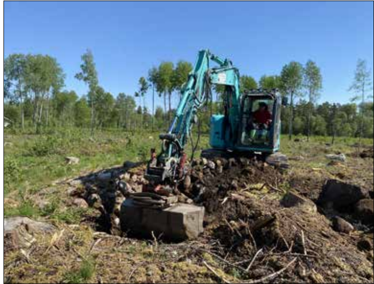
Figur 3. Schaktning genom ett av de 15 röjningsrösen som snittades med maskin. Detta undersöktes ej.
