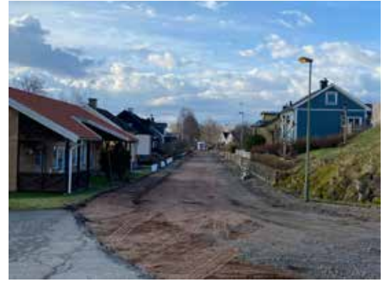
Figur 2. Västra Ågatan precis vid projektstart. Foto taget från N.
