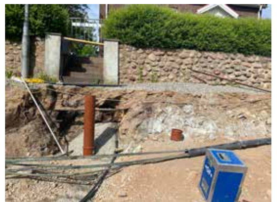
Figur 9. Den delen av Västra Ågatan där berg sprängts bort för att få ner ledningarna. Foto taget från Ö.
