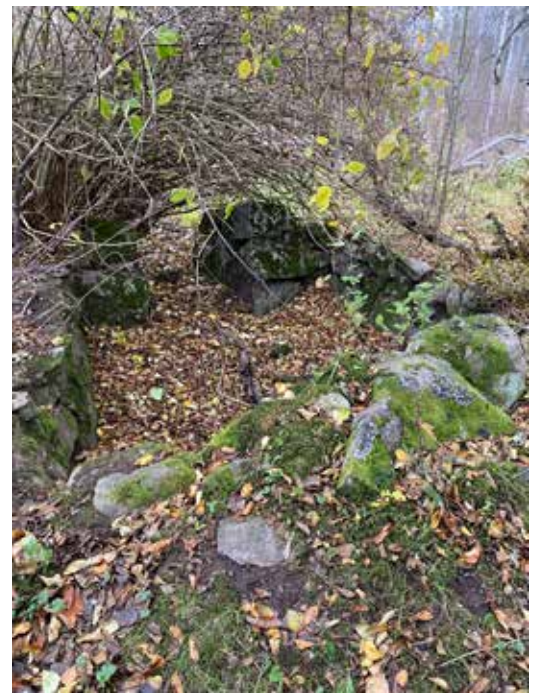
Figur 8. Jordkällare som hör till Kaxtorps by, belägen ungefär 150 meter från bytomten.
