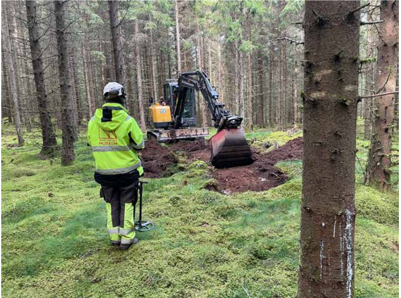
Figur 2. Schaktning pågår mellan stenarna.
