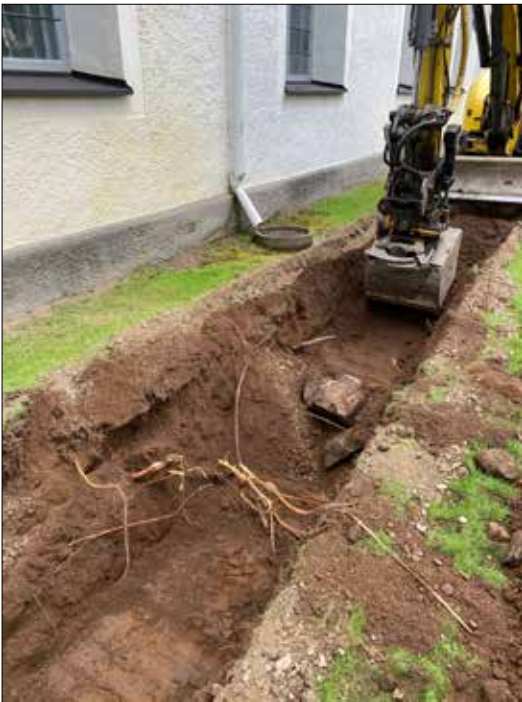
Figur 6. Rester efter stenkistor med de kantiga och lösa stenarna som framkom i schaktet.
