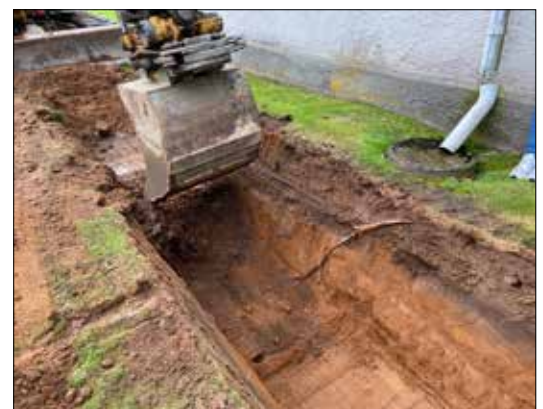
Figur 9. Den sotiga linjen syns tydligt i den södra schaktkanten, från sidoingången och österut mot tornet.
