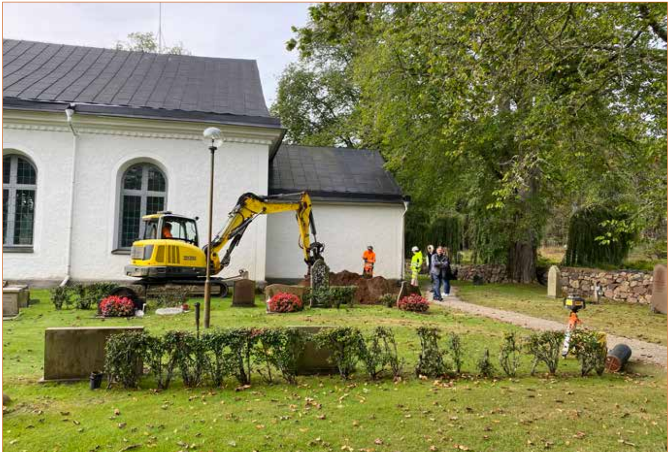
Figur 2. Schaktningarna börjar vid koret på den norra sidan. Foto från norr.
