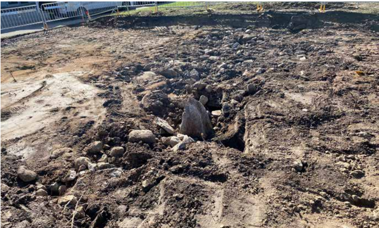
Figur 2. Raseringsmassor i ett av de schakt som togs upp i de områden som skulle saneras.
