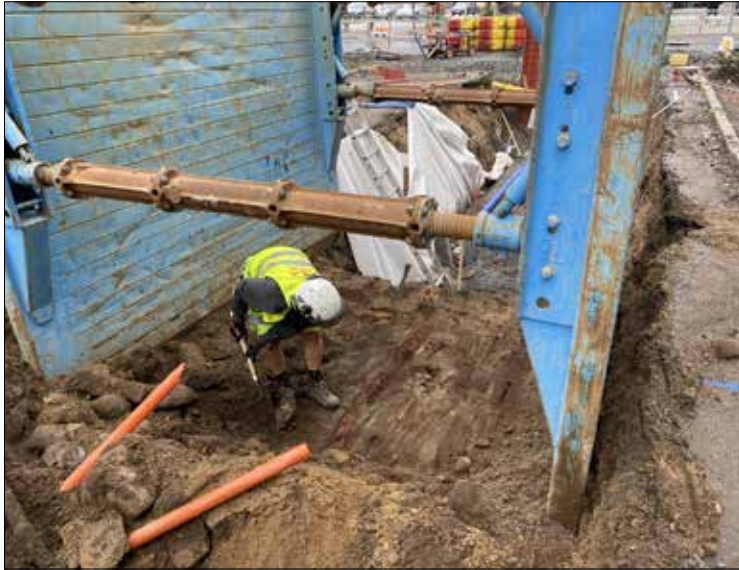
Figur 4. Rensningsarbete i schaktlådan. Foto från sydost.
