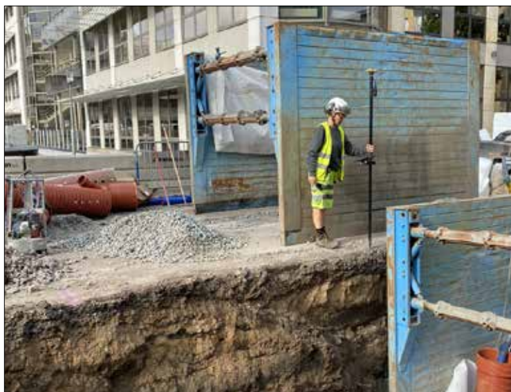
Figur 5. Inmätning av schaktlåda. Foto från ostsydost..
