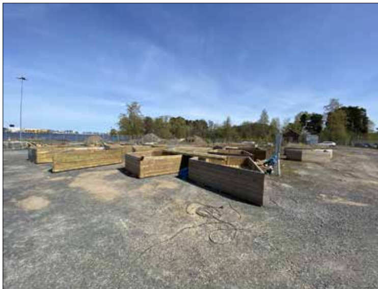
Figur 7. Område med odlingslådor i östra delen av fastigheten Övergången. I bakgrunden till höger skimtar pudretfabrikens manskapsbyggnad och vår manskapsvagn, och till vänster jordhögarna intill schakt 65–66.
