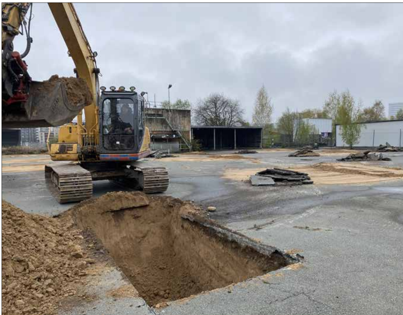
Figur 14. Schakt 57 i östra delen av fastigheten Ödlan. I norra profilväggen ses naturligt avsatta varviga sandlager. I bakgrunden har schakt 49–56 fyllts igen.
