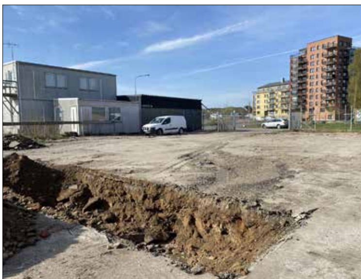
Figur 2. Exempel på ett av de mindre schakten, schakt 17, i nordligaste delen av fastigheten Ödlan (se även Figur 6). I bakgrunden skymtar några av de nya byggnaderna inom fastigheten.
