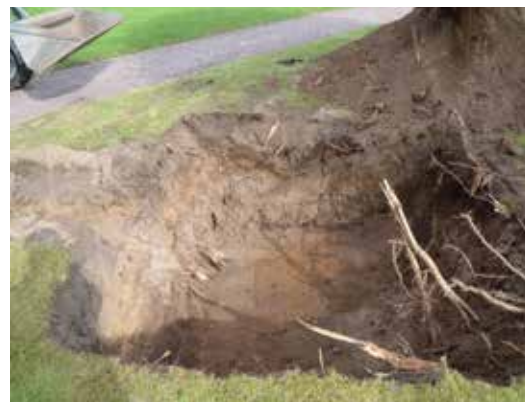
Figur 2. I det upptagna schaktets östra ände grävdes ett djupare schakt där vattenkassetter ska grävas ned. I schaktet påträffades påförd lera.
