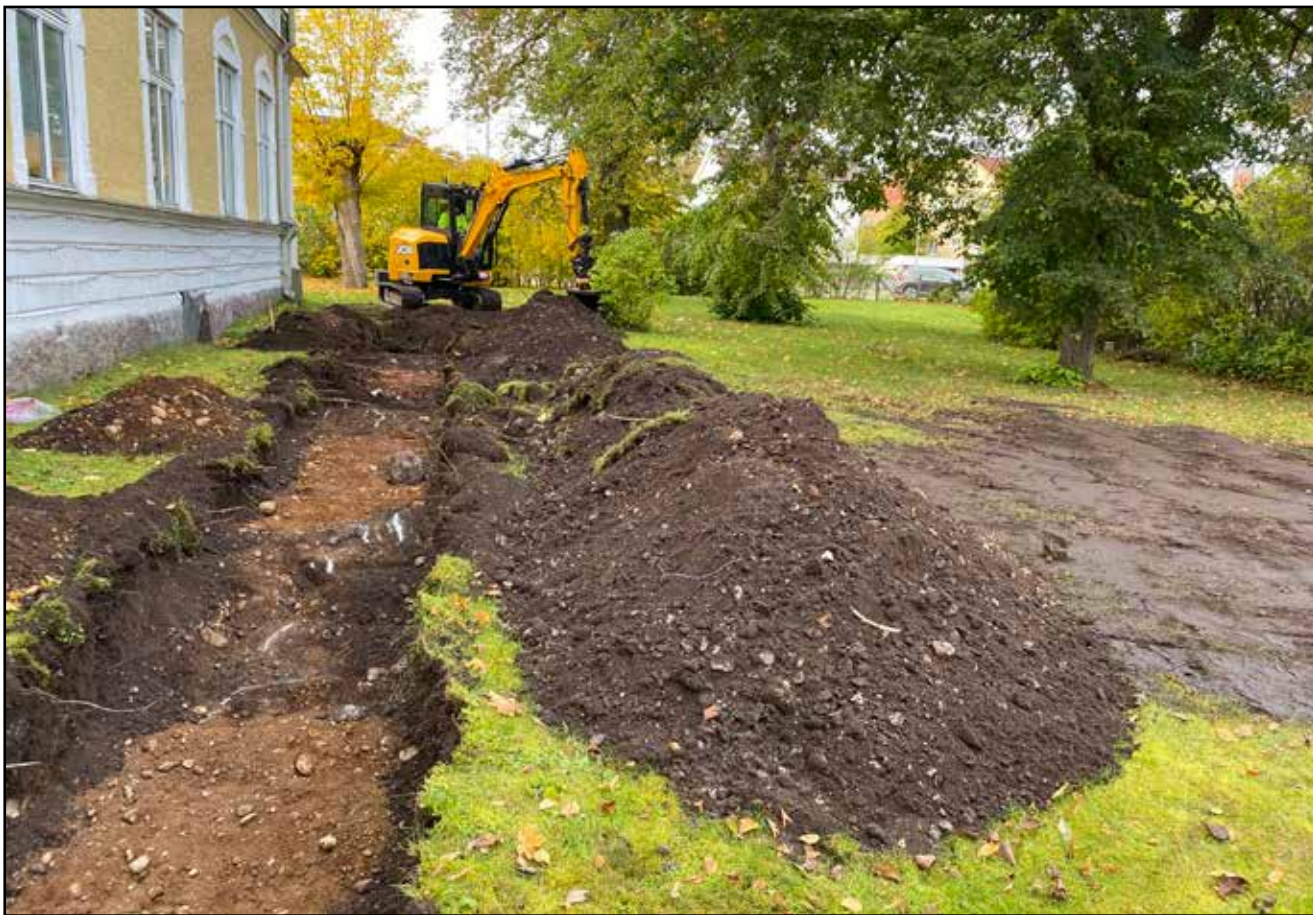
Figur 6. Schakt i område B, på husets norra sida. Schakten fylldes igen löpande, för att förhindra fallrisk i öppna schakt.
