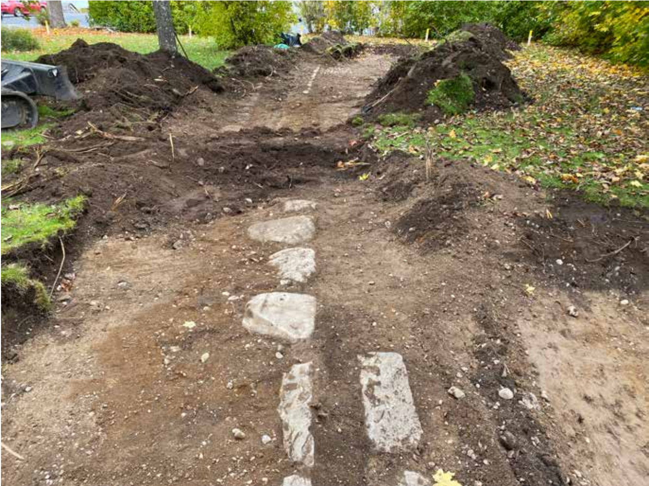
Figur 8. Syllstenarna i norra delen av schaktet i område C. I södra delen anas vägen i bild. Foto från norr.
