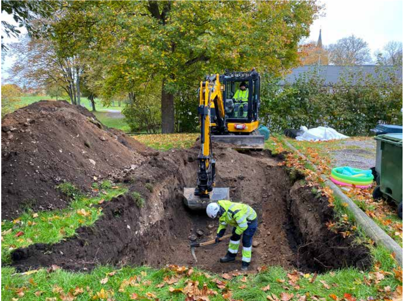
Figur 5. Schakt 1 i område A. I schaktets östra kant (i bild till vänster) ses det påförda gruslagret.
