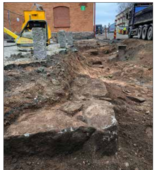
Figur 7. Hörnet på kajkanten som framkom i korsningen Österlånggatan/Brännerigatan. Foto från söder.
