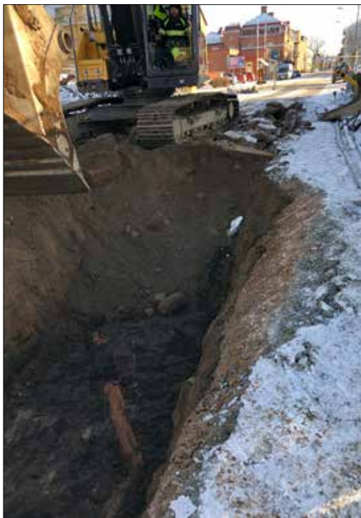
Figur 9. Schaktkanten i den västra delen. Här syns kulturlagret efter den äldre åfåran. I botten på schaktet en stock. Foto från norr.
