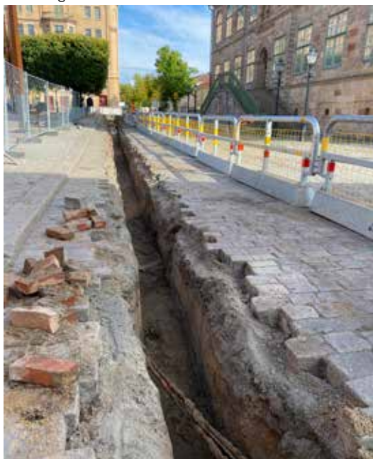
Figur 8. Schaktet var smalt och innehöll mycket störningar i form av ledningsdragningar från tidigt 1900-tal och framåt.
