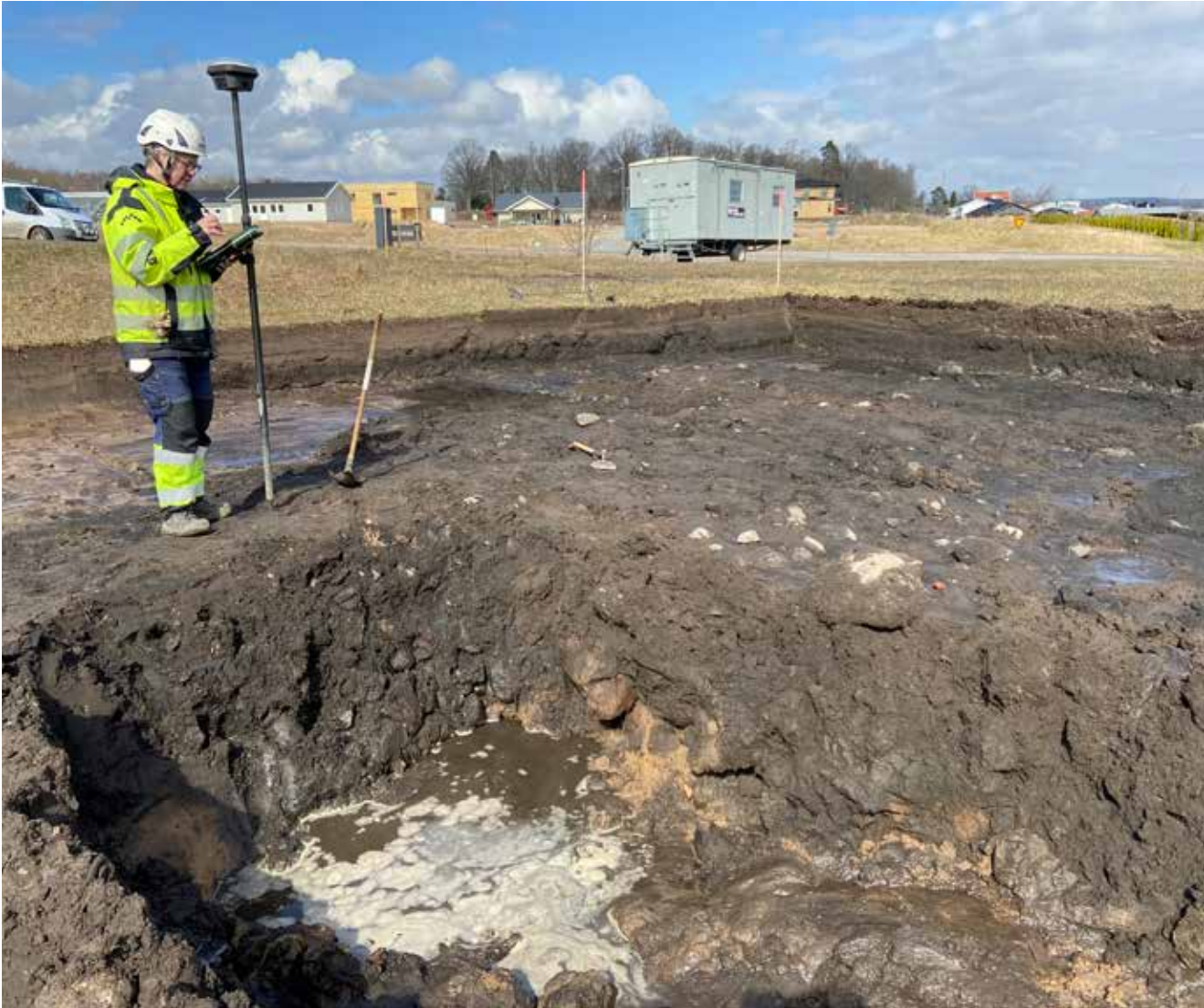
Figur 3. Ovan syns schaktet som togs för att med maskin utröna lagrets tjocklek i den djupaste delen. Den snabba vattentillförseln och koncentrationen av större stenar (0,2-0,4 meter stora) gör att man kan misstänka att det rör sig om en igenfylld brunn. Dock påträffades inga konstruktioner som utgjort brunnsväggar, så det kan likväl röra sig om en naturlig vattenfylld sänka. Foto från söder. Foto: Mikael Nordström.
