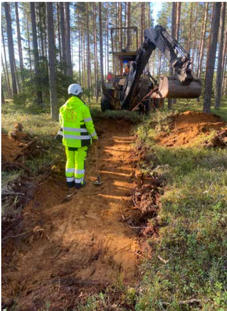
Figur 2. Emma övervakar schaktningen
