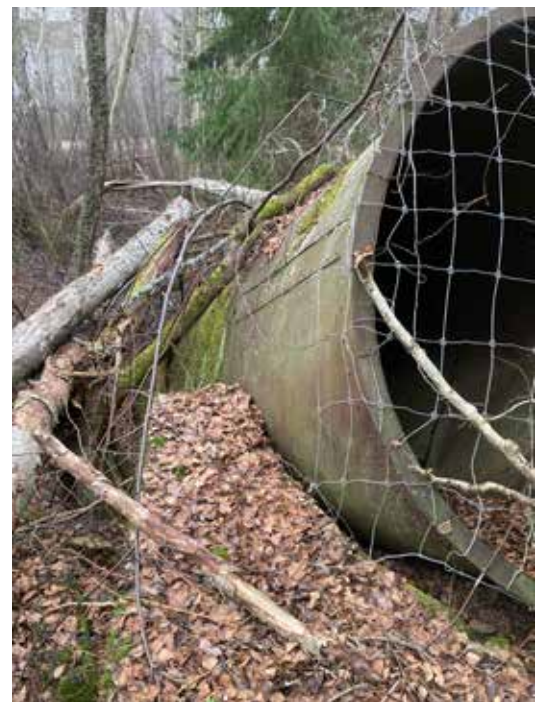
Figur 6. Järntrumma med minst 1½ meter i diameter och med för oss oklar funktion. I trummans botten fanns en avtappningslucka som ledde ut mot en större anläggning i cement.
