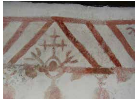
Prov på förstärkning av dekorationsmåleriet. Det äldre konserverade måleriet förstärktes med pigmenterat kalkvatten. De rekonstruktioner som var utförda på en KC-puts grundades vid behov först med pigmenterad kalkfärg.
