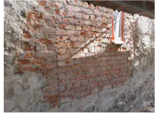
På korets södra fasad finns spår som visar att fönsteröppningens storlekt och form förändrats vid flera tillfällen.
