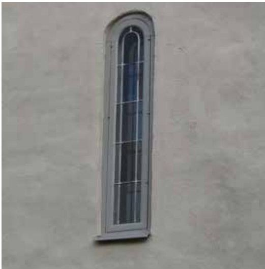
Fönstren ommålades med linoljefärg och bågarna kompletterades med kitt. Korets södra fönster fick ny blyspröjsning.
