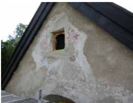
Detalj av sakristans gavelröste mot norr där man kan se hur den nya putsen ansluter mot de äldre putsytorna.
