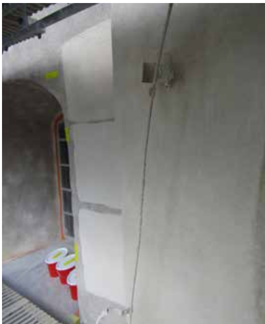
Kulören på tornets silikatfärg anpassades till Trilokalken kulör på långhuset. Det mittersta provet valdes.
