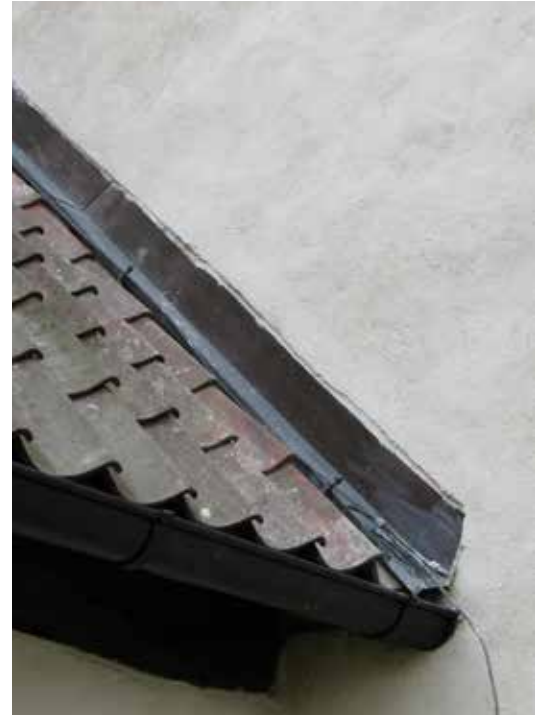
Putsen drogs inte ner över ståndplåtarna likt tidigare utförande, utan slutar strax ovanför plåten.
