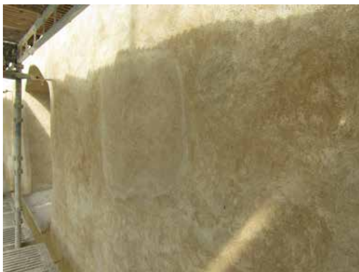
Detalj av långhusets södra fasad där den nya putsen slagits på. Ytan bearbetades med snutbräda när bruket blivit skurtorrt. I fotots mitt syns den referensytan som togs fram tillsammans med Kristin Balksten.
