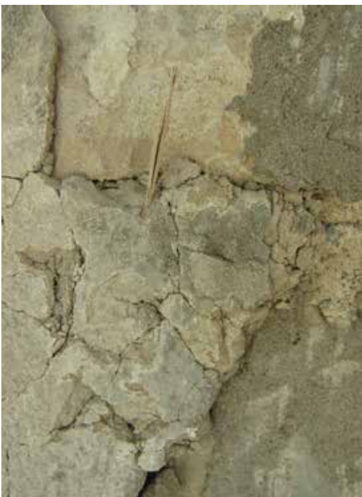
De äldre putsskikten hade armering i form av djurhår, men även växtfiber och större träflisor som ses på bild.
