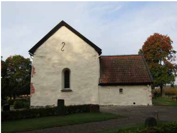
Putsen drogs inte ner över ståndplåtarna likt tidigare utförande, utan slutar strax ovanför plåten.
