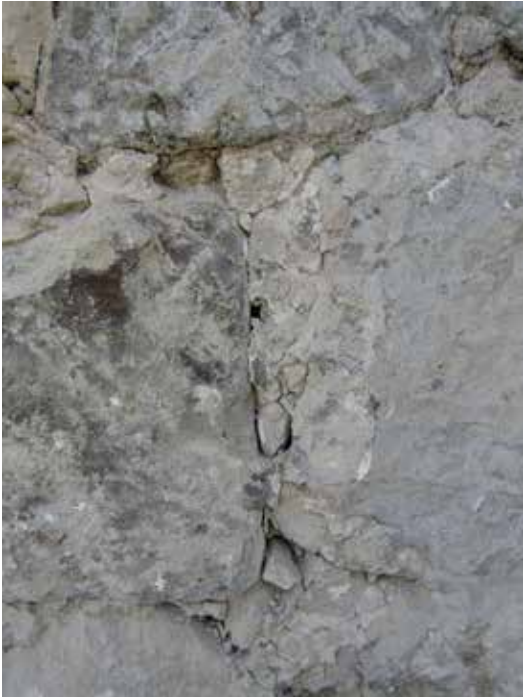
Detalj från långhusets norra fasad där rester av en kalkavfärgad puts ligger relativt djupt in mellan murverkets stenar.
