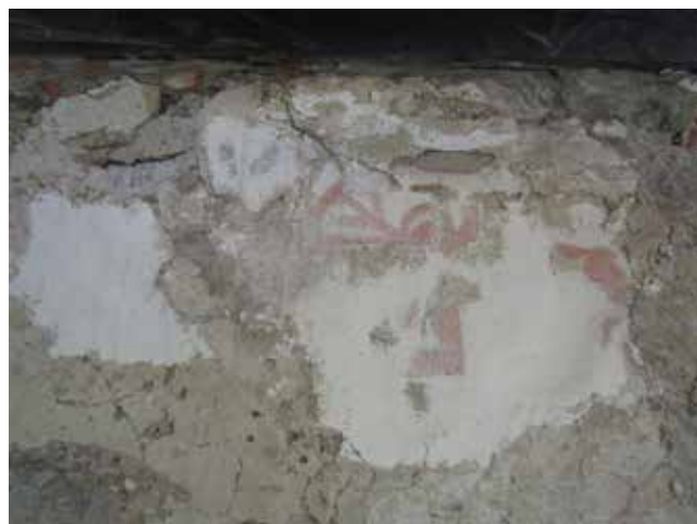
Detaljbilder från sakristans östra fasad.
