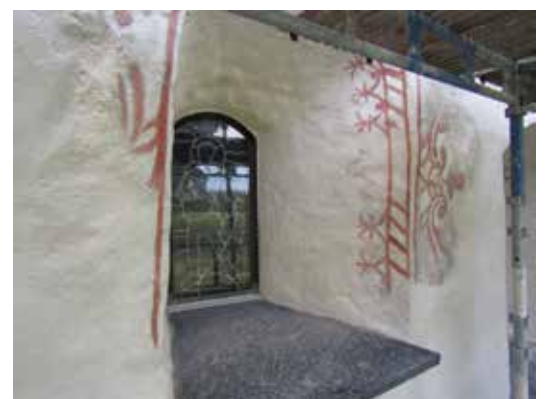
På det fragmentariska måleriet runt predikstolsfönstret förstärktes endast den dekor som var tydligt urskiljbar.
