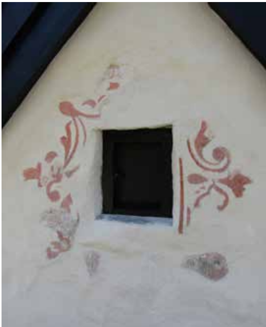
Runt vindsluckan i sakristians gavelröste finns måleri från olika generationer. Tydligt måleri förstärktes, medan det övriga lämnades blottlagt.
