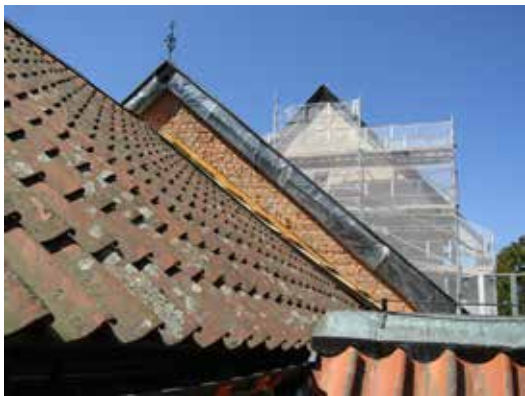
Långhusets östra gavel består av tegel och förefaller vara murad 1955.
