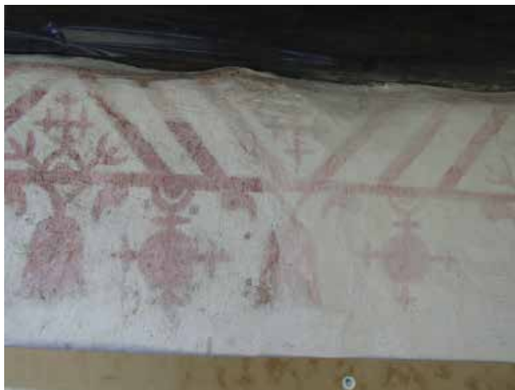
Detalj av dekorationsmåleriet längs takfoten vid långhusets norra sida. Till vänster ses det framtagna konserverade originalmåleriet och till höger det blekta rekonstruerade måleriet.
