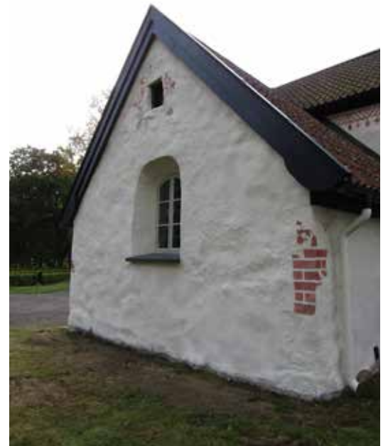
Foto av sakristians gavel mot norr. De äldre putsytor som förblev blottlagda anas som oregelbundna ytor med något gropigare yta.
