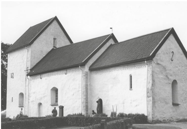
Kyrkan efter utförda konserveringsarbeten 1979. Delar av hörnens rekonstruerade dekorationsmåleri förefaller vara förstärkt. (JM_1987-1-2287)
