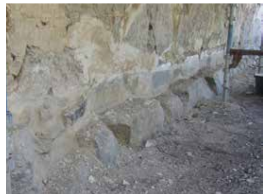
Vid korets östra gavel där det nedersta stenskiftet skjuter ut en bit från det övriga murverket.
