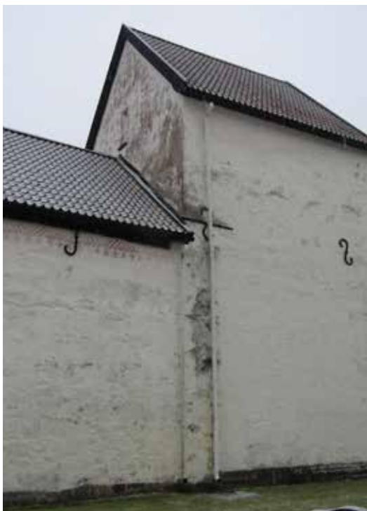
Tornet före åtgärder i februari 2024. Det förekom rikligt med algpåväxt, framförallt på västfasaden. Kalkavfärgningen hade dålig vidhäftning mot KC-putsens.
