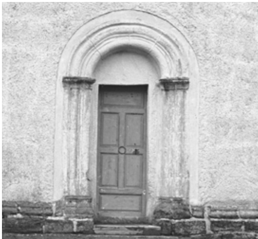
Västportalen år 1933 med en senare utbytt spegeldörr. Sandstensportalen var då kalkad. (ATA, Raä 2273-049)
