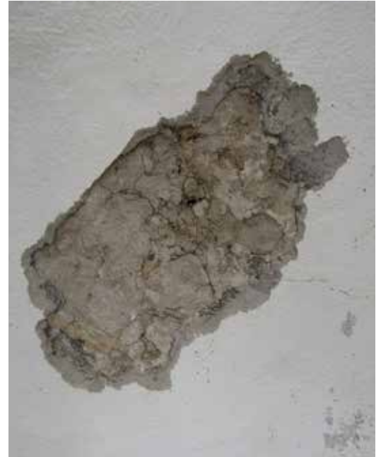
Provyta där den sentida putsen bilats bort med bilningsmaskin.
