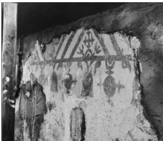
Detalj av framtaget måleri utmed takfoten. De mörka lagningarna är utförda med cementförstärkt bruk. (ATA, Raä 2273-028)
