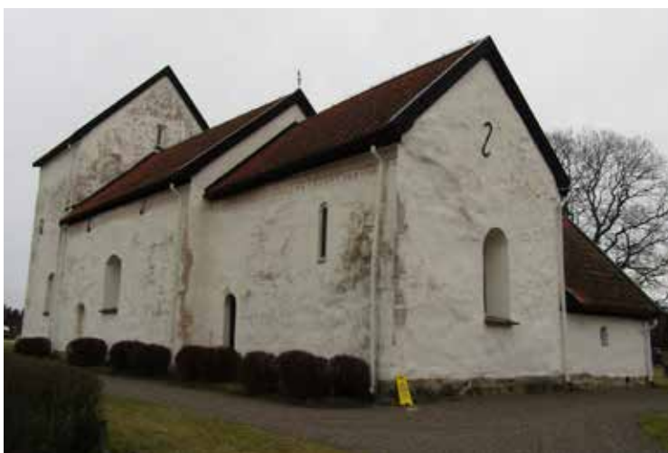
Fasaderna hade flera lager av kalkfärg med dålig vidhäftning.
