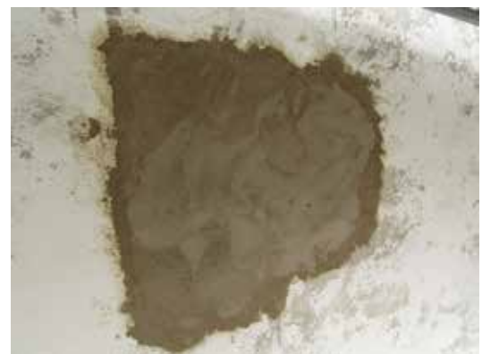
Provyta av den nya putsen tillverkad tillsammans med Kristin Balksten. Detta användes sedan som referensyta för det fortsatta arbetet.
