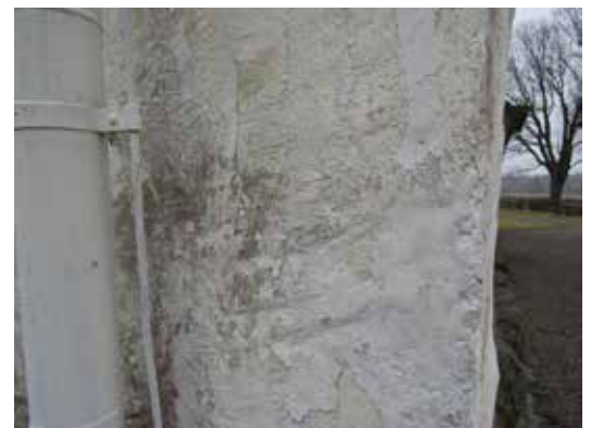
Fasaderna hade flera lager av kalkfärg med dålig vidhäftning.
