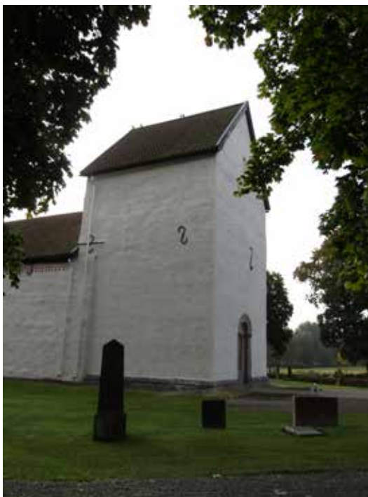
Bild från slutbesiktningen i september. Den norra fasaden fick ny kalkputs, övriga fasader lagades endast upp.
