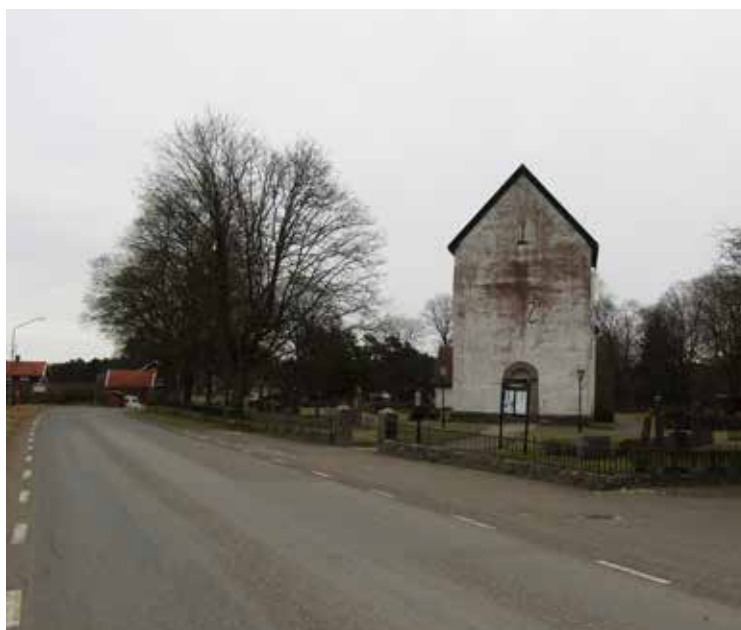
Tornet före åtgärder i februari 2024. Det förekom rikligt med algpåväxt, framförallt på västfasaden. Kalkavfärgningen hade dålig vidhäftning mot KC-putsens.
