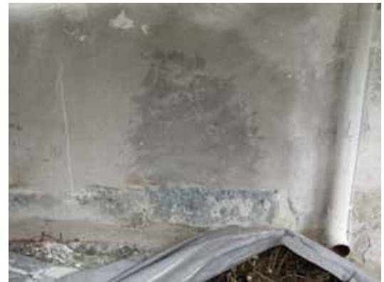
Provyta utförd med blästring. 1990-talets kalkputs försvann med denna metod, men inte 1950-talets KC-puts.
