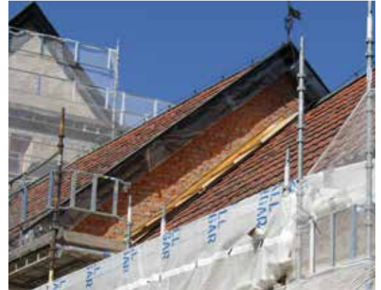
Långhusets östra gavel är helt murad av tegel, vilket utfördes på 1950-talet.
