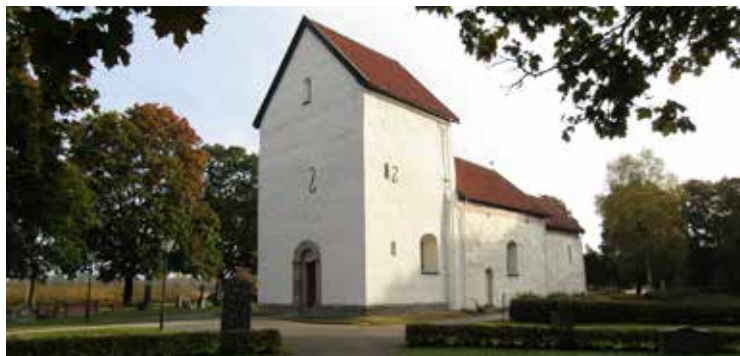
Norra Ljunga kyrka sedd från norr i september 2024 efter utförd renovering.
