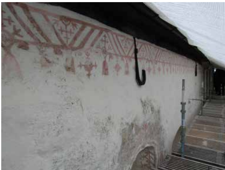
Dekorationsmåleriet utmed den norra fasadens takfot och runt predikstolsfönstret. Detta måleri är till stora delar ett äldre måleri med mindre rekonstruerade delar. Måleriet runt predikstolsfönstret antas tillhöra en äldre generations måleri och är mycket fragmentariskt.
