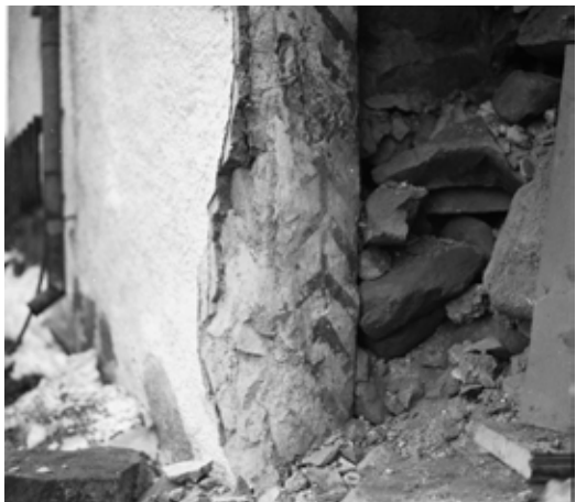
Långhusets sydportal togs upp i samband med arbetena 1955. (ATA, Raä 2273-022)
