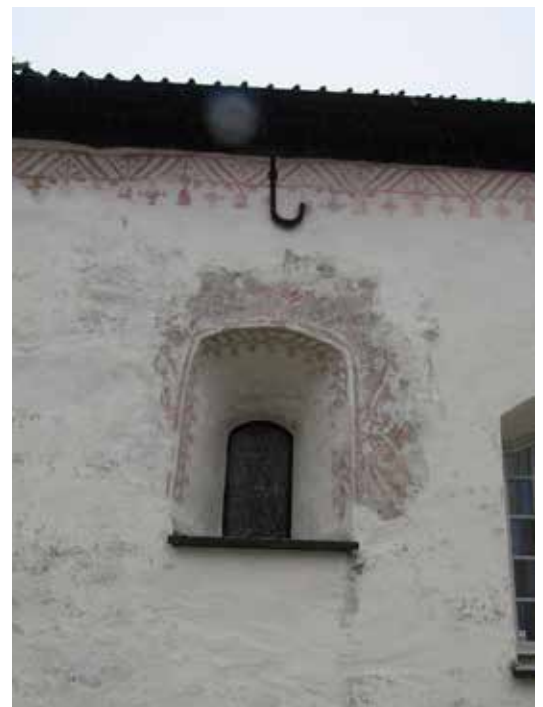
Dekorationsmåleriet utmed den norra fasadens takfot och runt predikstolsfönstret. Detta måleri är till stora delar ett äldre måleri med mindre rekonstruerade delar. Måleriet runt predikstolsfönstret antas tillhöra en äldre generations måleri och är mycket fragmentariskt.
