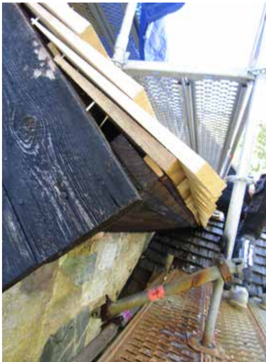
Den nya spåntäckning gjordes luftad vid takfoten genom att en smal list lades ovanpå nedersta läkten. Spånen förborrades och spikades därefter för hand.
