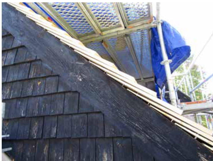
Spånen lades ut över vindskivorna och finhöggs för hand när de lagts på plats, likt tidigare utförande.
