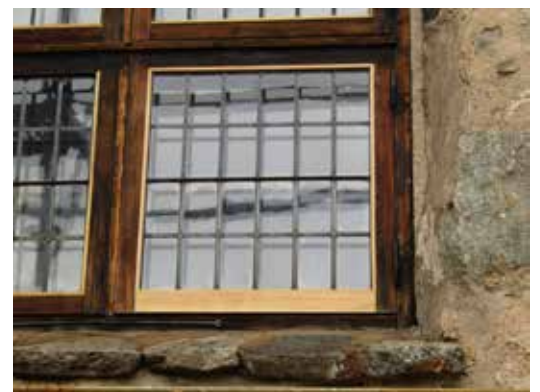
Rötskadade delar på långhusets södra fönster har ersatts av nytt virke.
