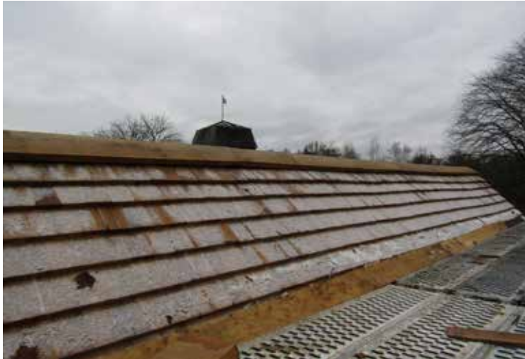
Taketsnockar försågs med nockbrädor av ek. Under dessa ligger de gamla nockplåtarna.
