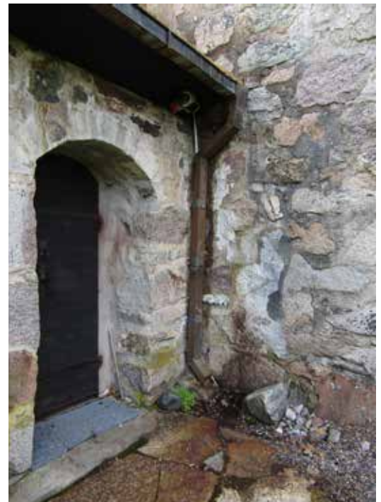
Stupröret som idag sitter i det inre hörnet mellan långhus och sakristia bör på sikt ges en annan placering.
