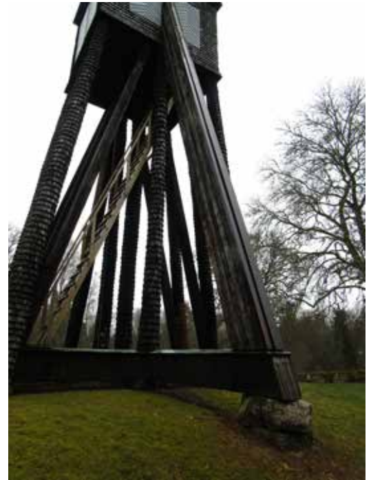
Klockstapelns västra stötta försågs med nya täckbrädor.
