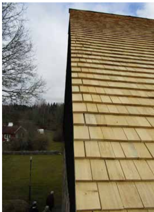
Spånen lades ut över vindskivorna och finhöggs för hand när de lagts på plats, likt tidigare utförande.
