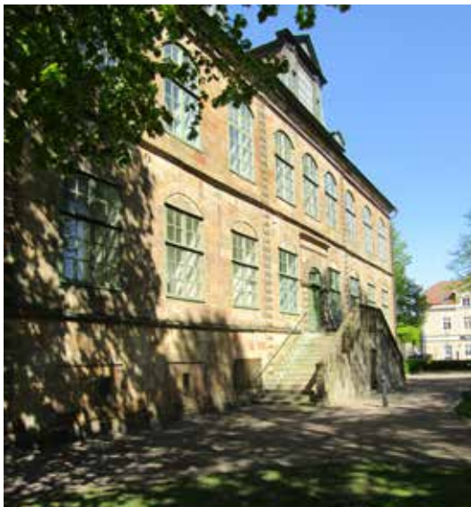
Den södra fasaden inför igångsättning av arbetena.
