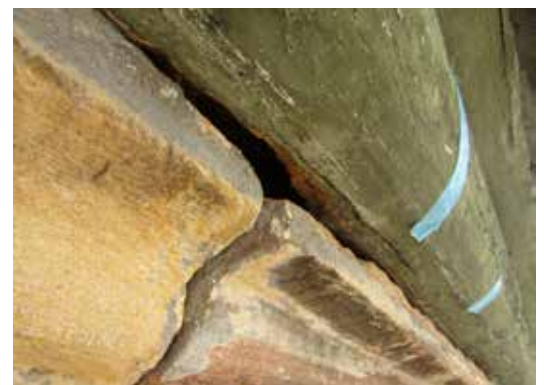
Ovan: Gamla rötskador hade medfört att stocken i takfoten givit upphov till glipor.
