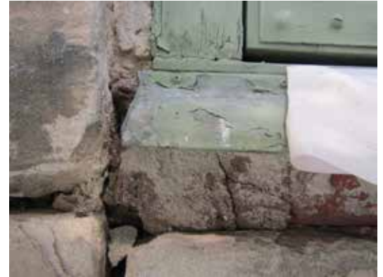
Fönster nummer 9 var det enda som hade en i karmbottenstycket infälld plåt fäst med torx-skruvar inför arbetena.
