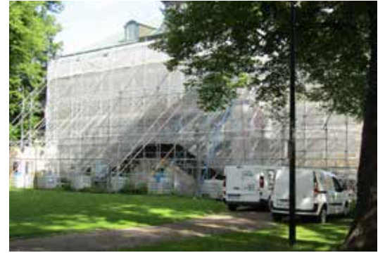
De resta byggnadsställningarna uppfördes helt utan infästningar i den känsliga fasaden.
