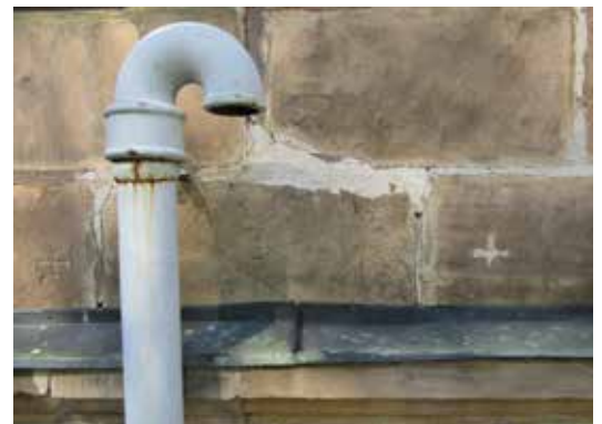
Ventilationsröret som kapades
