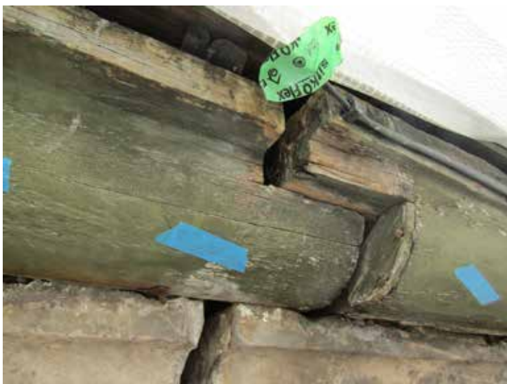
Ovan: Gamla rötskador hade medfört att stocken i takfoten givit upphov till glipor.
