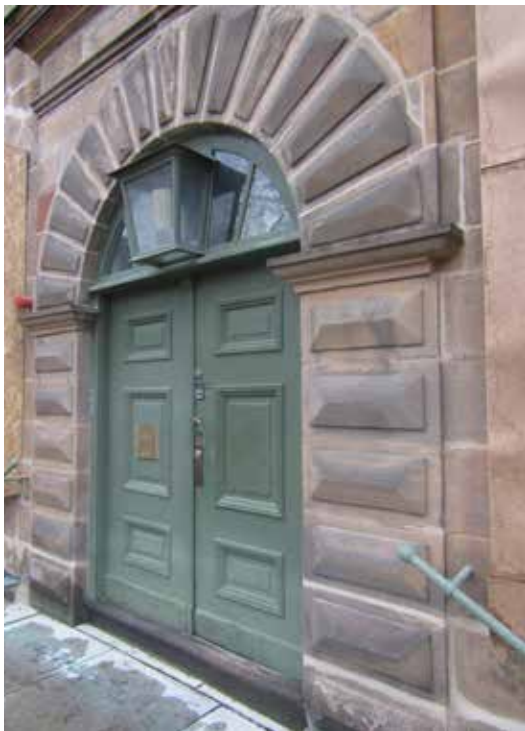
Den södra ingången efter avslutade arbeten.
