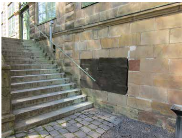
Till höger: Parti av den södra fasaden med fogar i olika kulörer.
