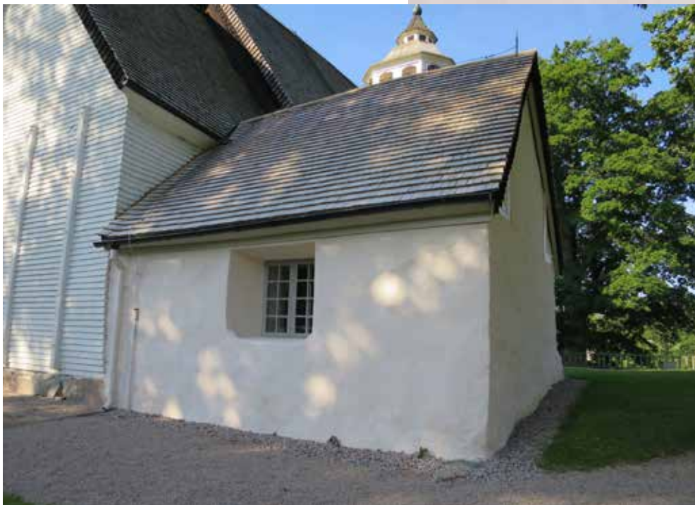
Sakristians östra sida med nylagt spåntak.
