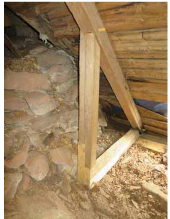
Den rötskadade västra knäbocken till andra takstolen närmast kyrkans kor efter lagning.
