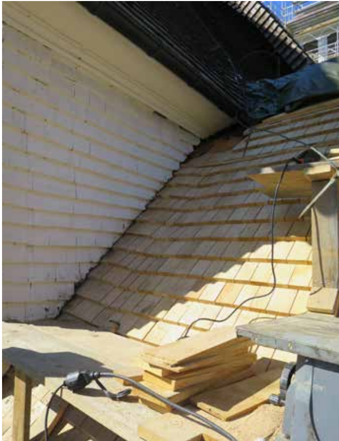
Sakristians östra takfall underläggning. Mot korfasaden lades björknäver under spånen.
