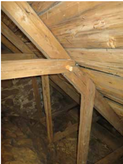
En ersatt dymling till hanbjälkens östra fäste i takstol 4 (räknat från norra gaveln).
