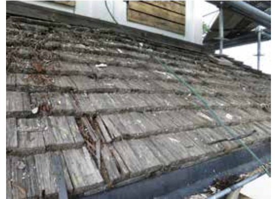
Närbild av tornets nedre spåntak 2023 som visar på spånens mycket bristfälliga skick.
