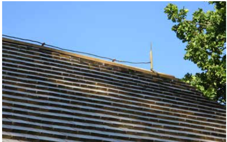
Efter moteringen av åskledaren med nya fästen i koppar.
