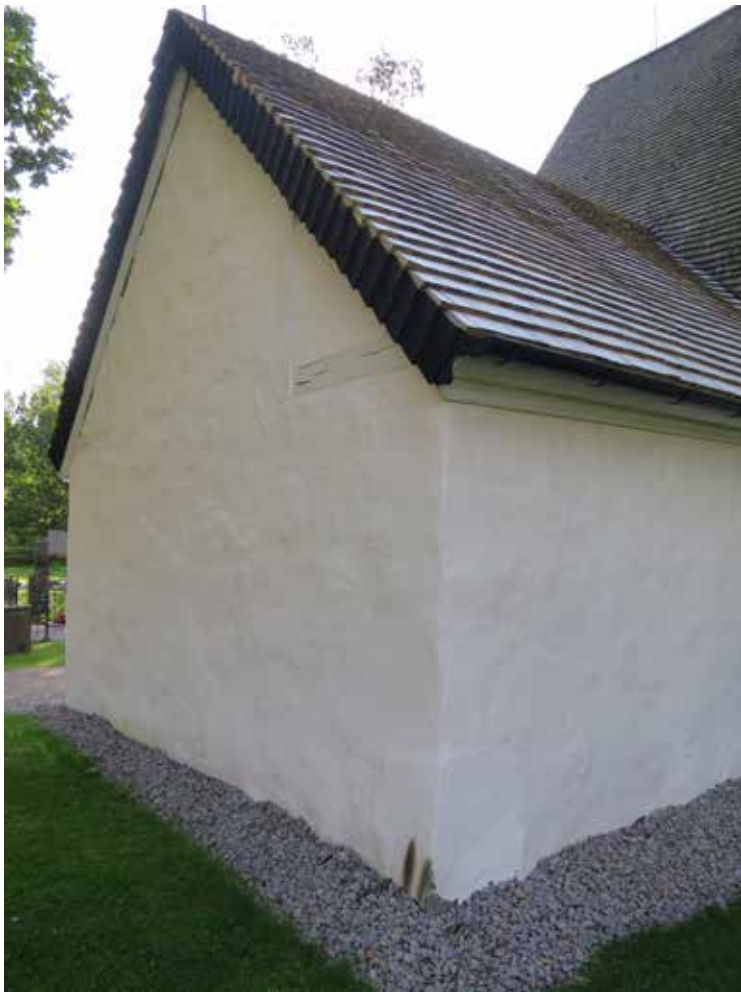
Till vänster spåntaketets möte med vindskivans äldre spåntäckning. Ovan östra takfallets läggning vid rännalden.
