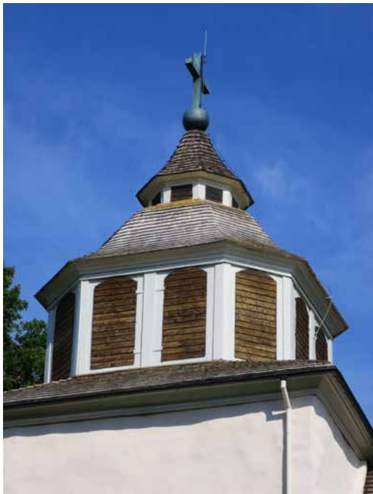
Till höger tornet med nylagd spåntäckning på taken till torn och lanternin. Övre lanterninens spåntak bibehölls. Övan syns det nya spåntaket på sakristians östra takfall vid anslutningen till fasad.
