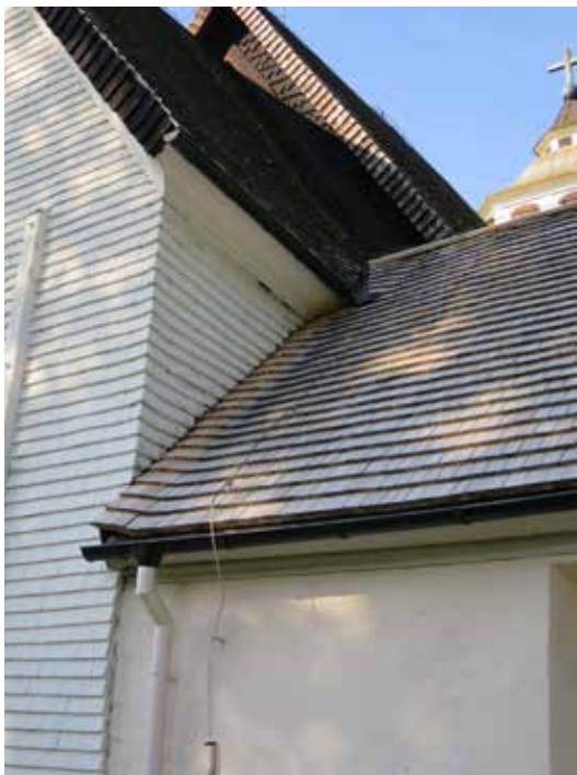
Till höger tornet med nylagd spåntäckning på taken till torn och lanternin. Övre lanterninens spåntak bibehölls. Övan syns det nya spåntaket på sakristians östra takfall vid anslutningen till fasad.
