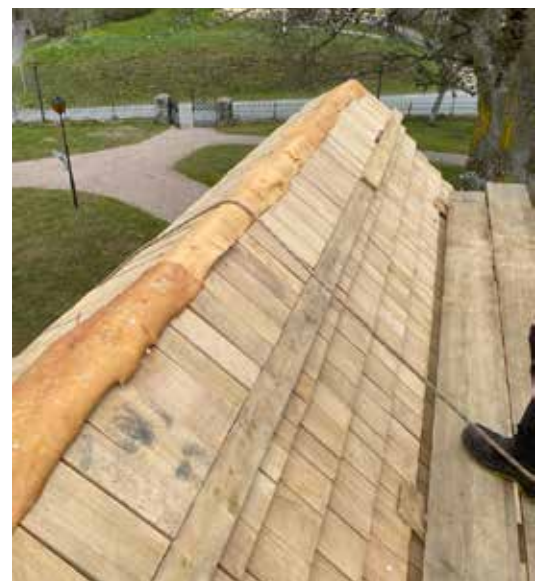
Under den nya brädnocken på sakristians tak lades björknäver.
