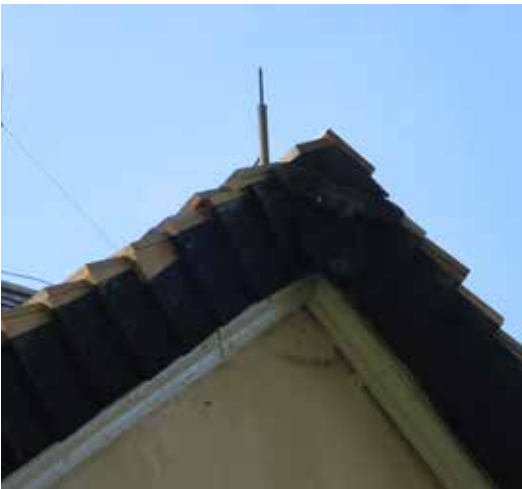
De nya nockbrädorna vilar på det äldre emblemet vid gavelspetsen.
