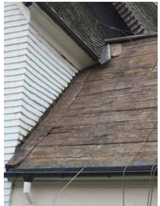
Del av den ålderdomliga taksvallen av handkluvna brädor på sakristians östra takfall.
