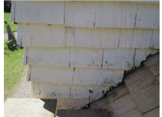
Ett parti av norra korfasadens spåntäckning som bestod av mycket breda ekspån.
