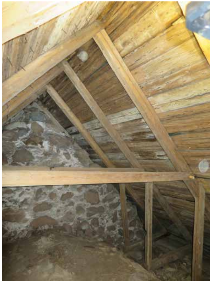
En ersatt dymling till hanbjälkens östra fäste i takstol 4 (räknat från norra gaveln).
