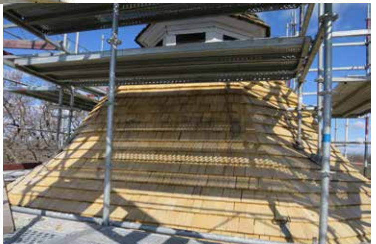
Nya anslutningslister i ek under lanterninens fasad. Ett extra spånskift lades under listan på de lägre takytorna.
