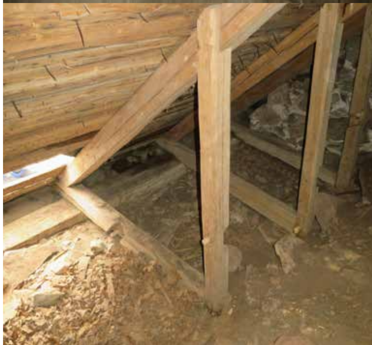
Stödben till takstol nummer 3 (från norr) åter infäst i sin tass med nya dymlingar.
