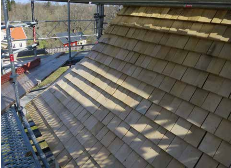
Den nya spåntäckningen på lanterninens huv, följde dess svängda form.
