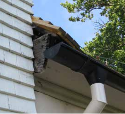
Det östra takfallen sticker ut några decimeter vid den östra korväggen. Här sitter en äldre tjärad vindskiva, med smidd spik, vilken behövs orörd vid takarbetena.
