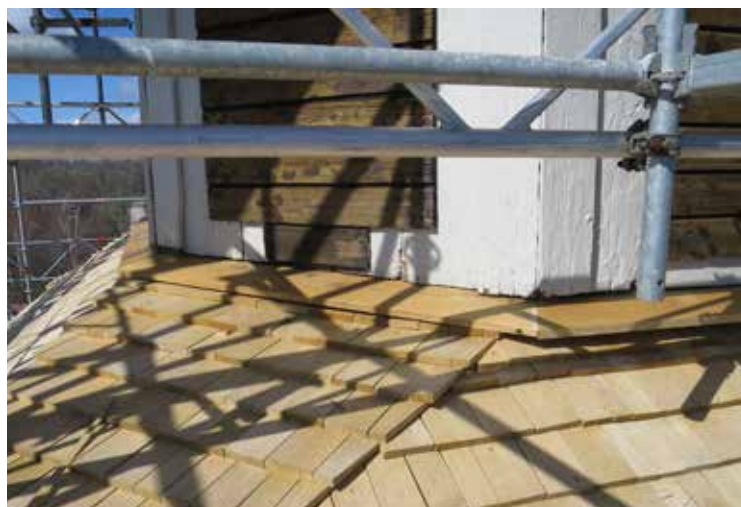
Nya anslutningsbrädor av hyvlad ek monterades vid tornetakets möte med lanterninen.
