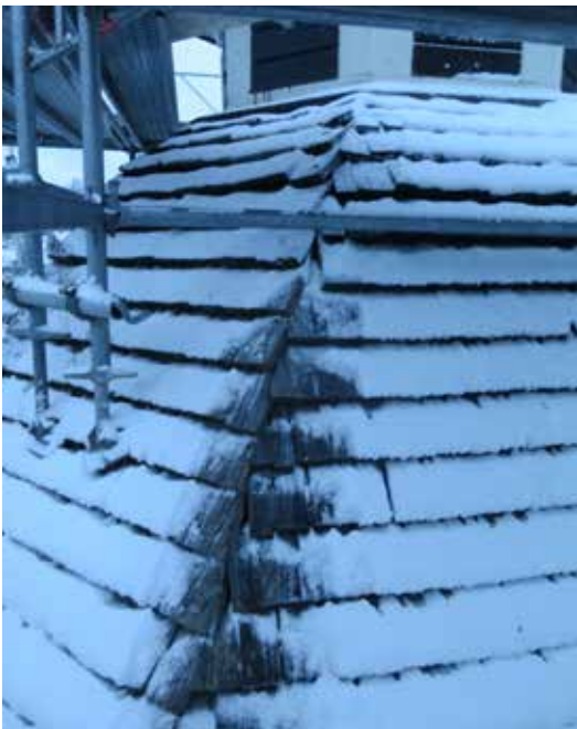
Spåntäckningen på den nedre lanterninens huv i januari 2024. Den var lagd med s k stumskarv vid hörnockarna.
