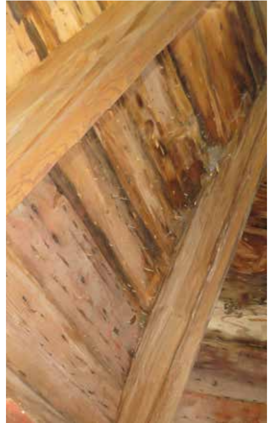
Insidan av tornhuvud där inga urfläckningar hade uppstått av spånspiken. Däremot förekom det en hel del synlig spik.
