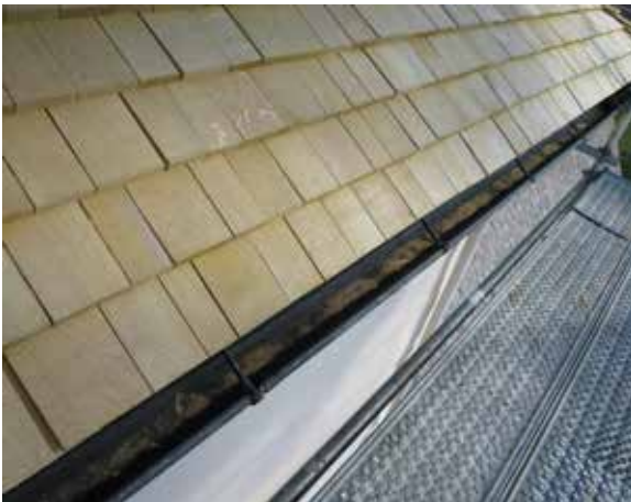
I takfoten till tornet lades dubbla spånskift och ingen luftningslist.
