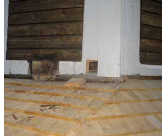
En av lagningarna i lanterninens fasadpanel.
