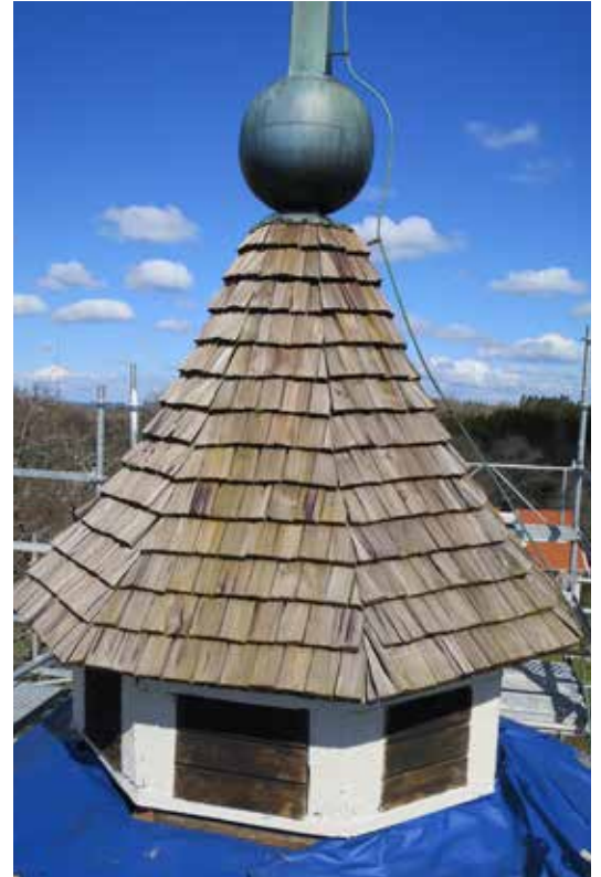
På tornets övre lanternin fanns en äldre taktäckning av handkliven furuspån, sannolikt från 1926. Denna var i ett gott skick och kunde därmed lämnas utan omläggning.
