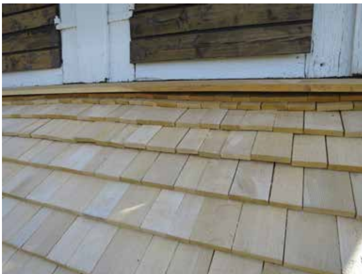
Nya anslutningslister i ek under lanterninens fasad. Ett extra spånskift lades under listan på de lägre takytorna.
