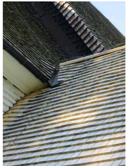
Till vänster spåntaketets möte med vindskivans äldre spåntäckning. Ovan östra takfallets läggning vid rännalden.
