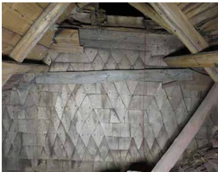
Den bevarade senmedeltida fasadbeklädnaden av handkluvna ekspån på korets norra fasad, synlig från sakristians vind.
