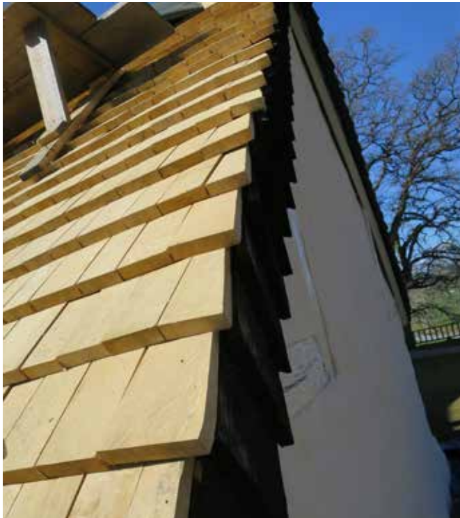
Sakristians östra takfall underläggning. Mot korfasaden lades björknäver under spånen.
