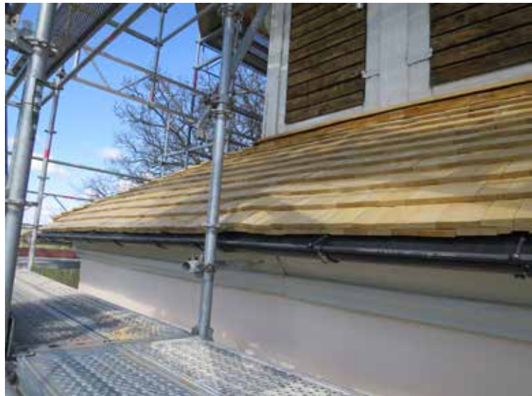
Torntakets valmade hörn lades med ovanpåliggande täckning.
