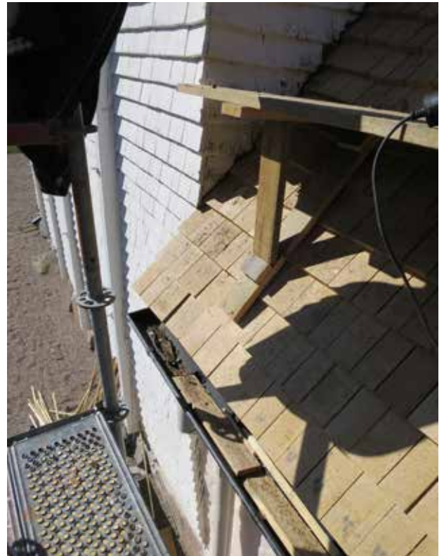
Nedre skiftet förlängdes något för att få till en god vattenavrinning i hängrännan.
