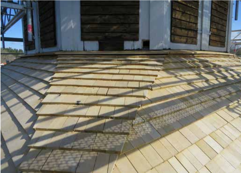
Torntakets valmade hörn lades med ovanpåliggande täckning.
