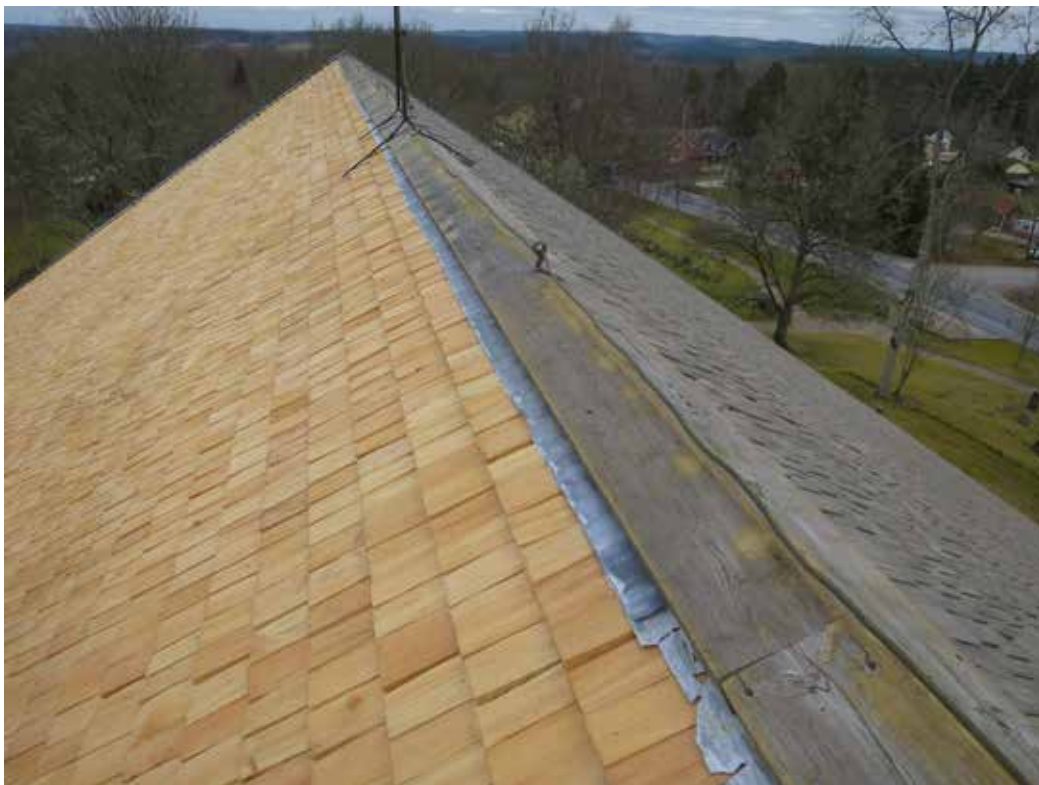
Befintlig brädnock, med blyplåt under, bibehölls. Här syns de äldre åskledarefästena i smide vilka kompletterades med nya handsmidda kopior.
