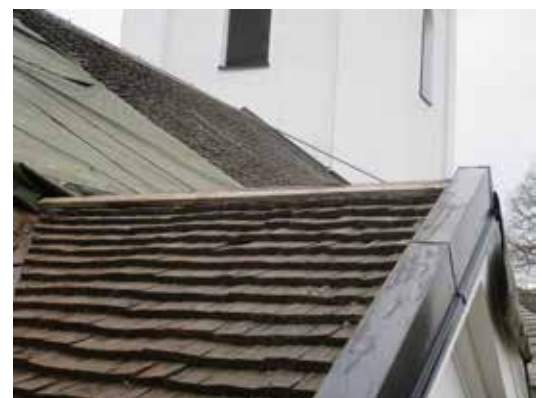
Frontonens tak med sentidanockbrädor och vindskivor i fabriksbockad och lackerad plåt.
