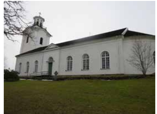
Korsberga kyrka före påbörjat takarbete i januari 2024.
