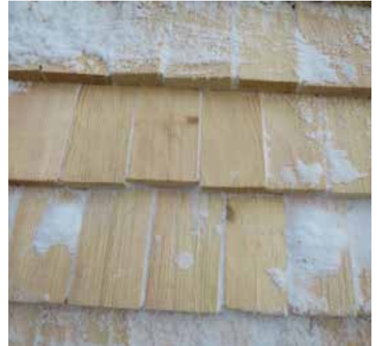
Spånen som levererats från Finland hade yta som efterbearbetas med yxa.
