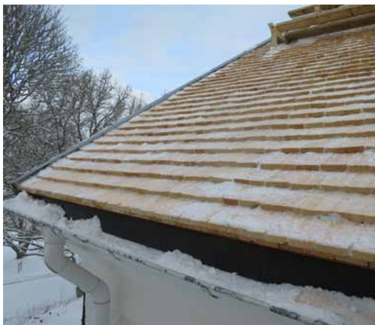
Den nylagda spåntäckning längst åt norr på taket i februari 2024.
