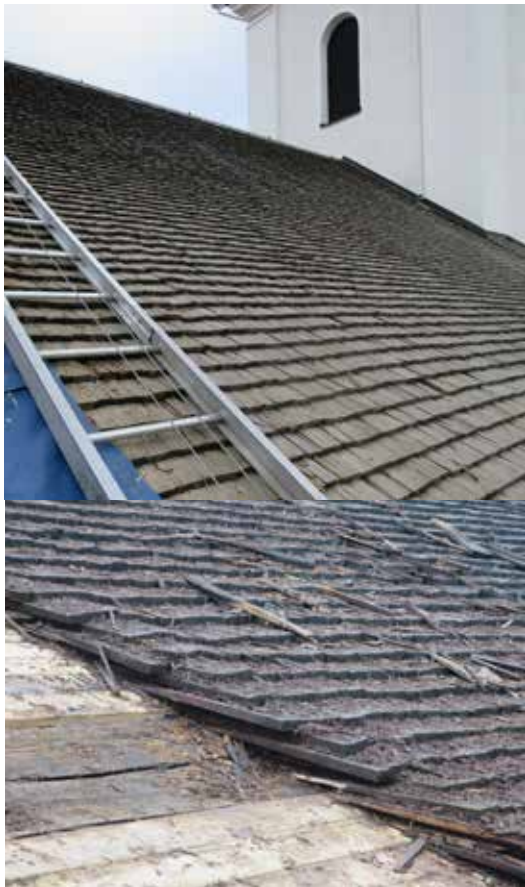
Ovan: Spåntaket under pågående rivning 2024. Till höger: Befintlig brädnock med blyplåt under. Nedan: Spåntaket sett från tornet 2020 där generalskarven på västra takfallet kan skönjas.
