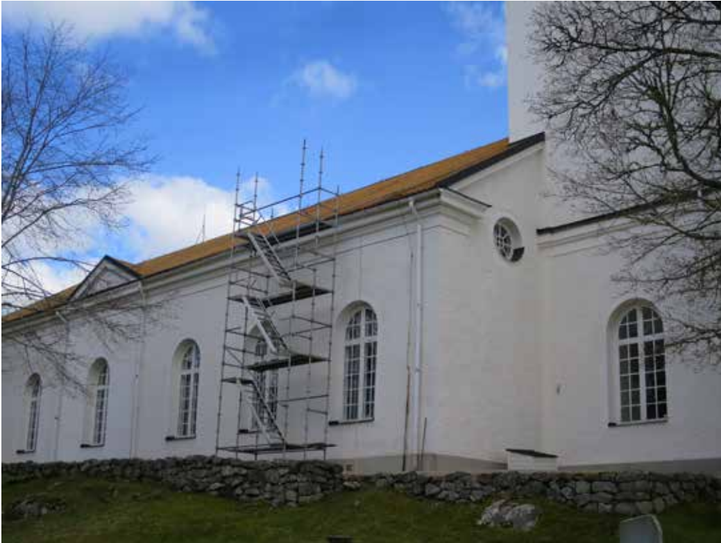
Kyrkans västra takfall efter färdigställd omläggning.
