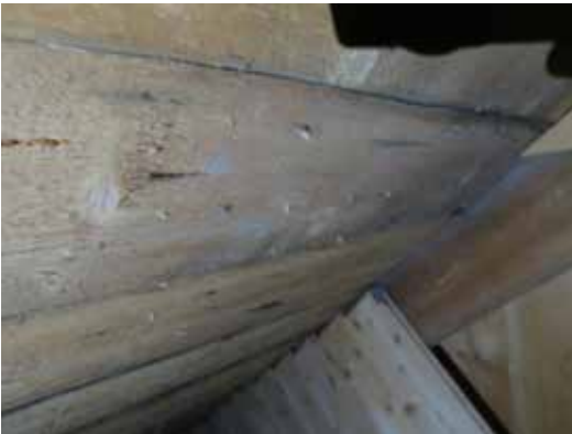
Spikens längd anpassades så att den endast i marginell utsträckning kom att gå igenom spånbotenpanel. Dessutom valdes en spetsig spik som inte kom att orsaka några urfläkningar på panelens insida.
