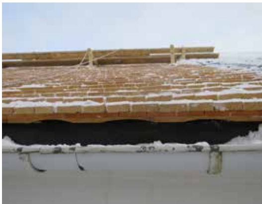
Luftningslisten och startskiftet under det nedersta spånskiftet vid takfoten.
