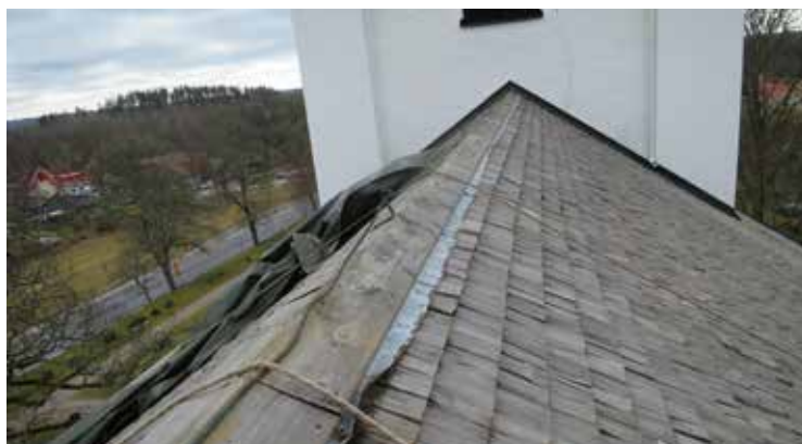
Ovan: Spåntaket under pågående rivning 2024. Till höger: Befintlig brädnock med blyplåt under. Nedan: Spåntaket sett från tornet 2020 där generalskarven på västra takfallet kan skönjas.
