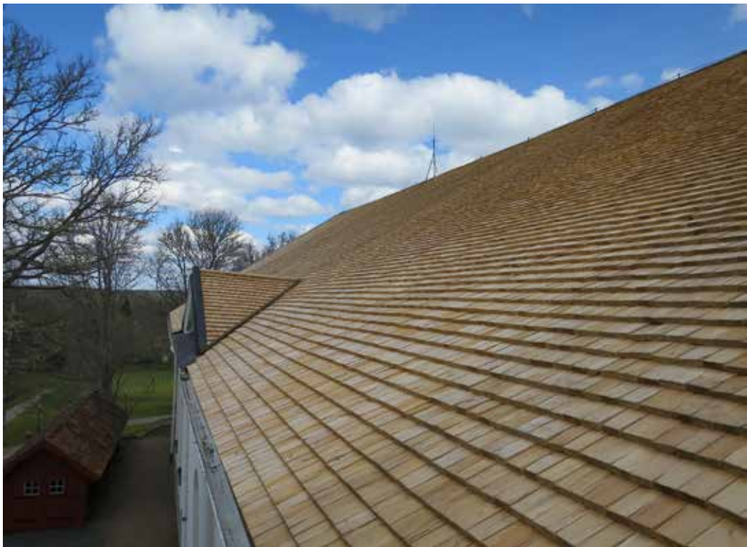
Takfallet lades i sin helhet om med maskinklurna obehandlade kärnfurusån.
