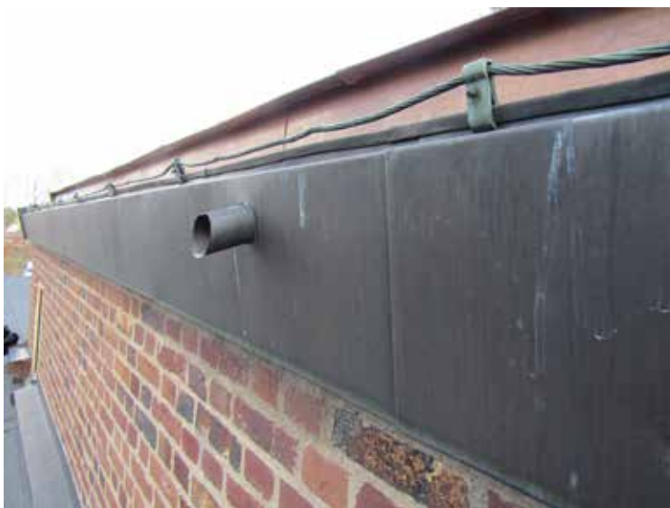
De yttre delarna av fotrännorna bevarades med vattenutkastare, som fanns för att säkerställa vattenavledningen om de invändiga stuprören inte skulle tjäna sitt syfte.
