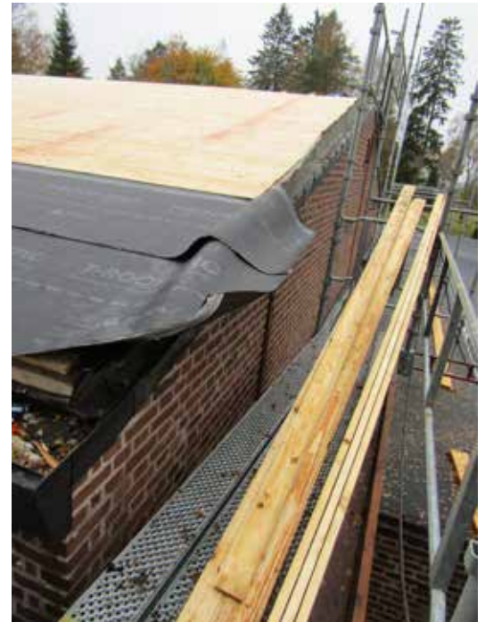
Ovan: Ny takbotten av råspont där papp läggs ovanpå. Till vänster: Takomläggningsarbete närmast gavelsidan. Den äldre plåtavtäckningen som skall bevaras viks undan temporärt.
