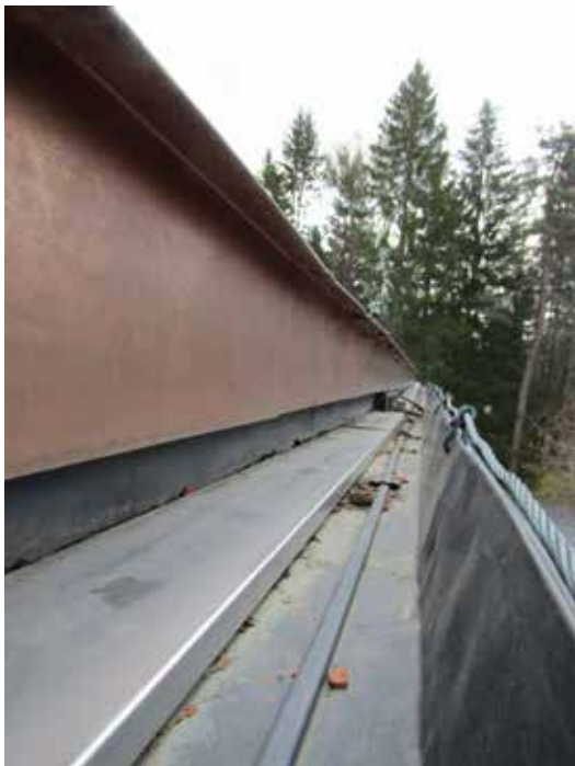
Ovan: Insidan på fotrännan med den nya luftningskonstruktionen till vänster.
