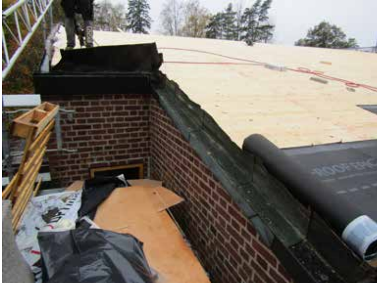
Ovan: Ny takbotten av råspont där papp läggs ovanpå. Till vänster: Takomläggningsarbete närmast gavelsidan. Den äldre plåtavtäckningen som skall bevaras viks undan temporärt.
