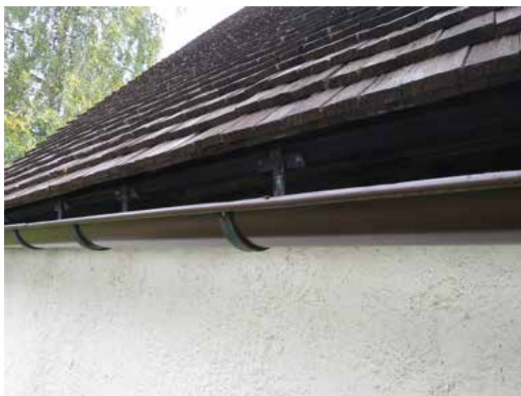
Plåten i ränn dalarna bibehölls men kompletterades med en ny stålplåt i nederkanten för att erhålla ett tätare utlopp på spåntaket.
