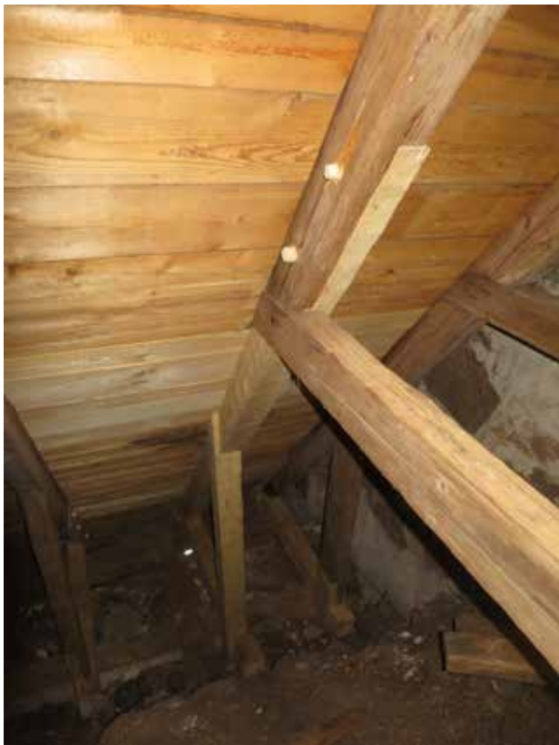
Större lagning av högbenet i takstol 2.
