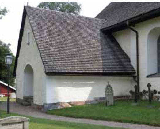
Sakristinas västra takfall före rivning av spåntäckning.
