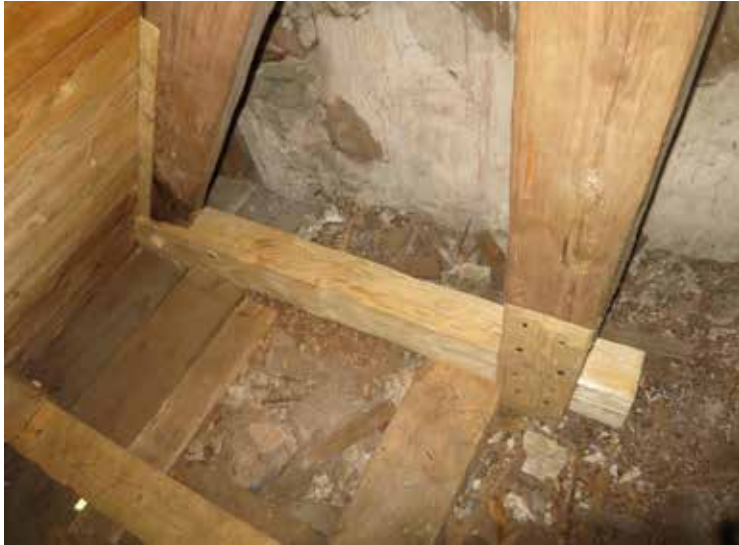
Två nya tassar samt ilagad ände till stödben till den två innersta takstolarna på östra sidan. Den nya infällda sektionen av det inre remstycket syns även här.
