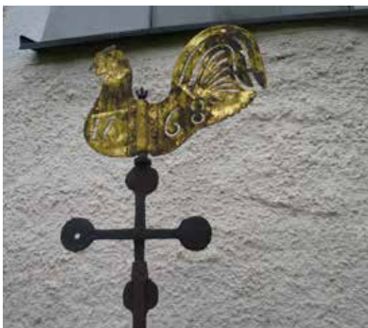
Den förgyllda tuppen på smidesspirans topp bär det instansade årtalet "1768". Spiran har därmed sannolikt tidigare suttit på tornet, vilket uppfördes detta år.
