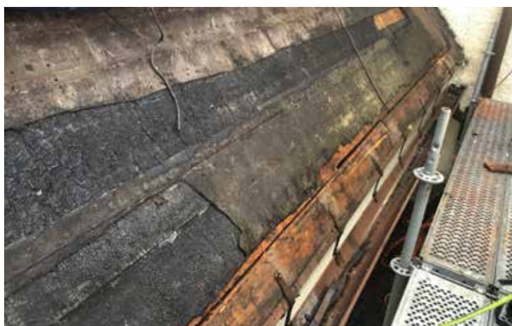
Papptaket från 1901 bestod av liggande pappsvåder med tjärdränkt papp struken med stenkoltjära. Pappen var spikad med klippspik i zic-zac mönster utmed underkanterna.
