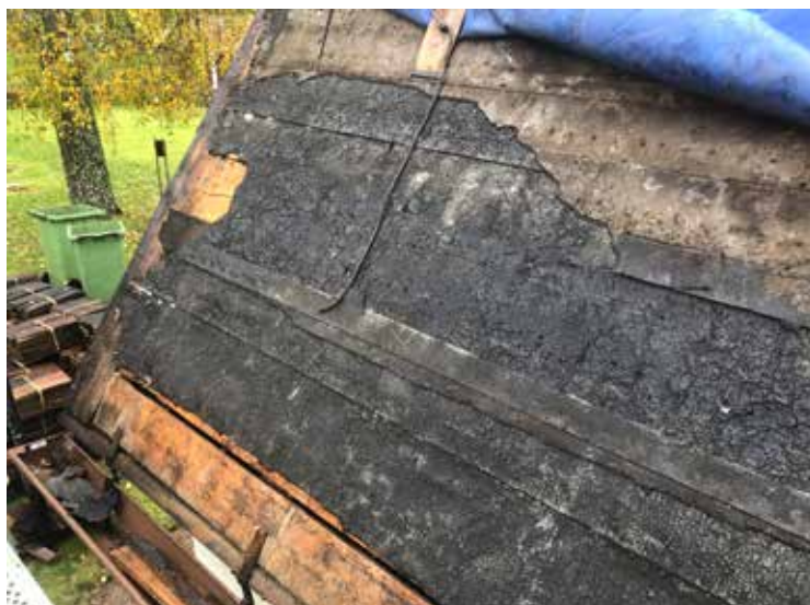
Den västra rännalen mellan sakristians och långskeppets norra takfall. I denna påträffades ett lager med tjärpapp, svartplåt därpå och överst dagens fabrikslackerade plåt. Notera även hålet i taksvallen som kan härröra från en äldre ställningsinfästning.
