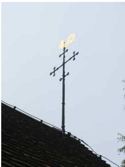
Smidesspiran från 1768 återmonterad efter ommålning och förgyllning.
