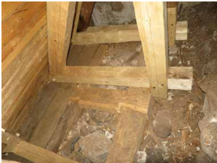
Ny rekonstruerad s k bindare mellan remstyckena åt öster.
