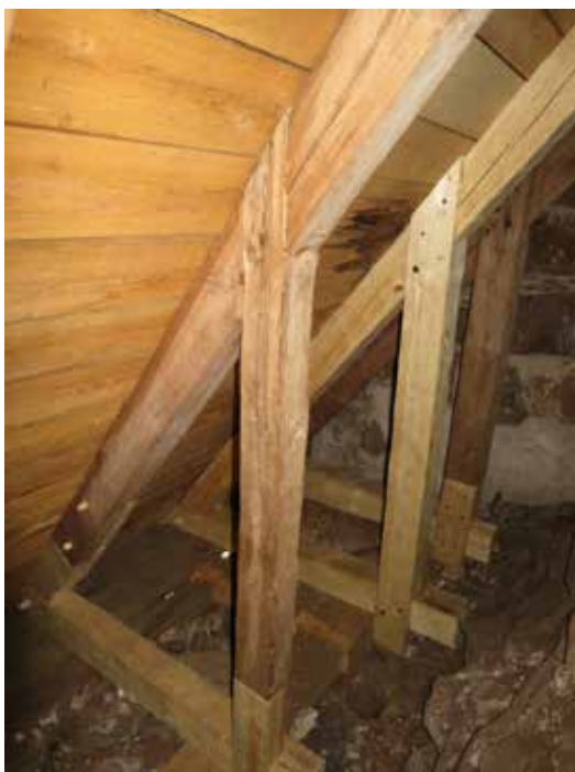
Takstolslagningarna på tunnvalvets östra sida.
