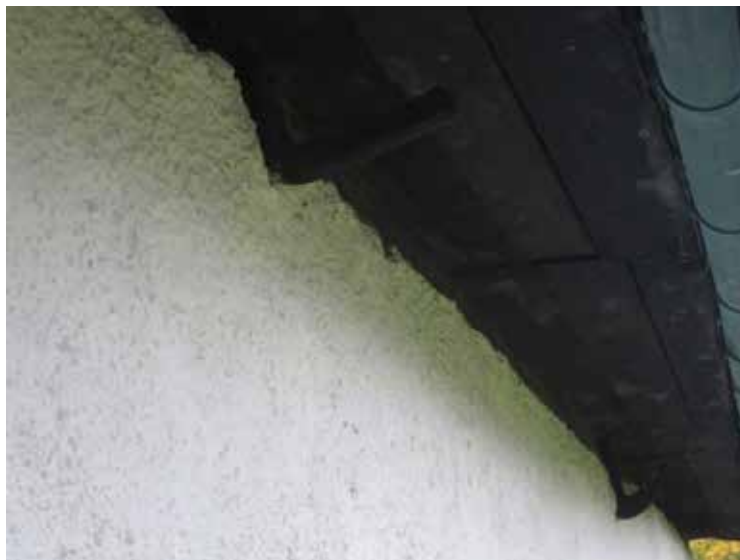
Del av sakristians norra gavel. Denna var sekundärt påbyggd, sannolikt för att passa den nuvarande takstolen. Till höger syns bevarade ålderdomliga träkrokar utmed långhusets norra remstycke.
