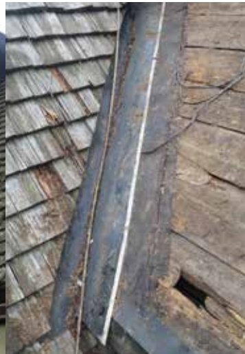
Rännal av fabrikslackerad plåt med takpapp under.
