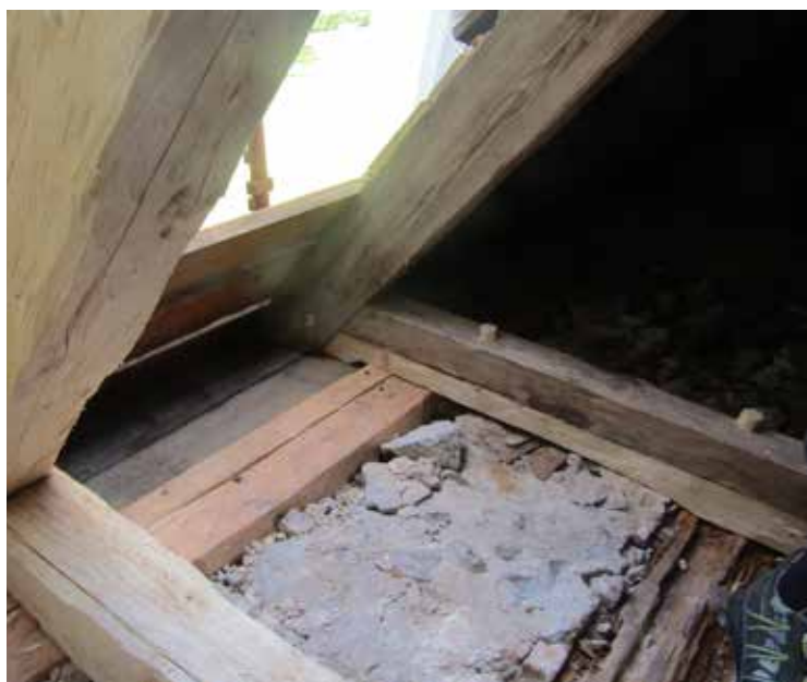
I den tredje takstolen gjordes enbart en halvsulning i tassens undersida.
