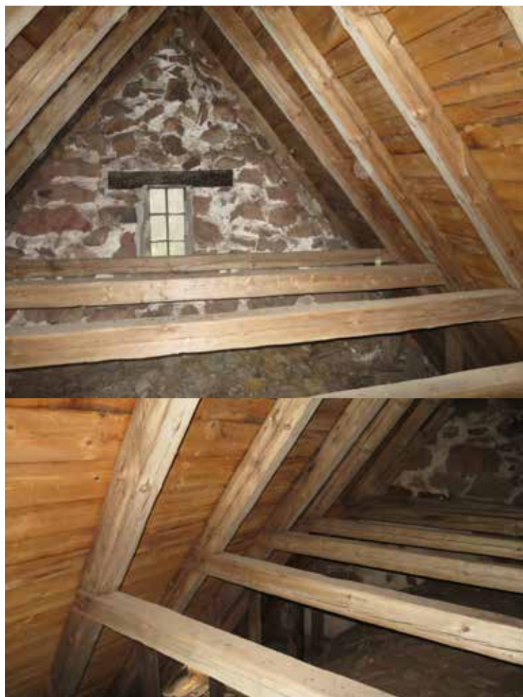
På murkrönens båda remstycken vilar takstolarna med sina knäbockar. Här syns en del av tunnvalvet samt takstolens östra upplag.
