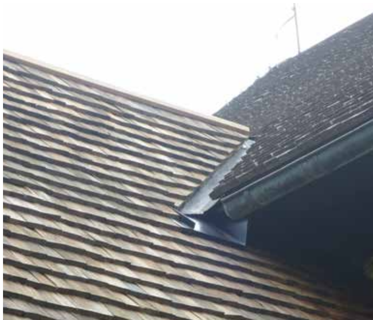
Plåten i ränn dalarna bibehölls men kompletterades med en ny stålplåt i nederkanten för att erhålla ett tätare utlopp på spåntaket.
