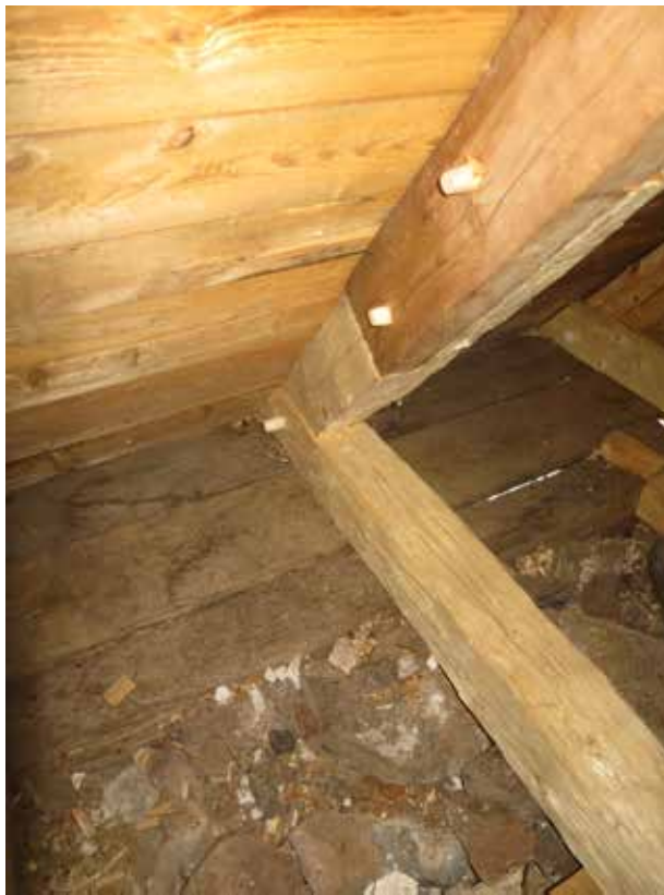
Mindre lagning av högbenet samt byte av tass i takstol 3.
