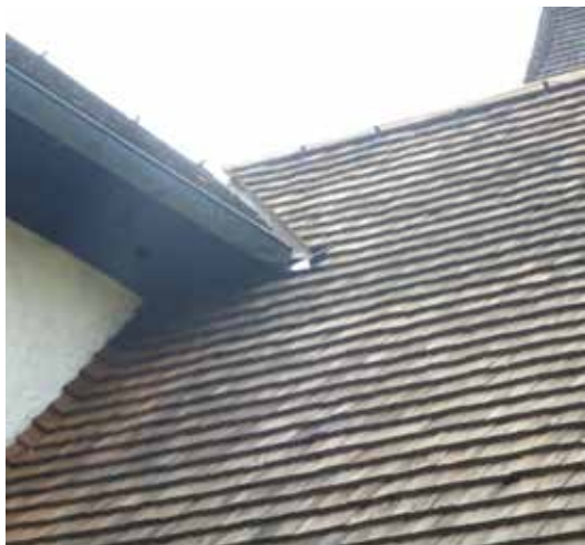
Den förlängda ränn dalen på sakristians östra takfall.
