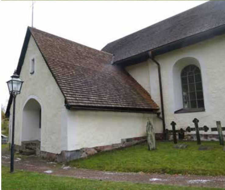
Sakristian efter färdigställd spåntäckning och med nyanockbrädor.
