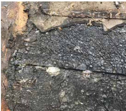
Papptaket från 1901 bestod av liggande pappsvåder med tjärdränkt papp struken med stenkoltjära. Pappen var spikad med klippspik i zic-zac mönster utmed underkanterna.
