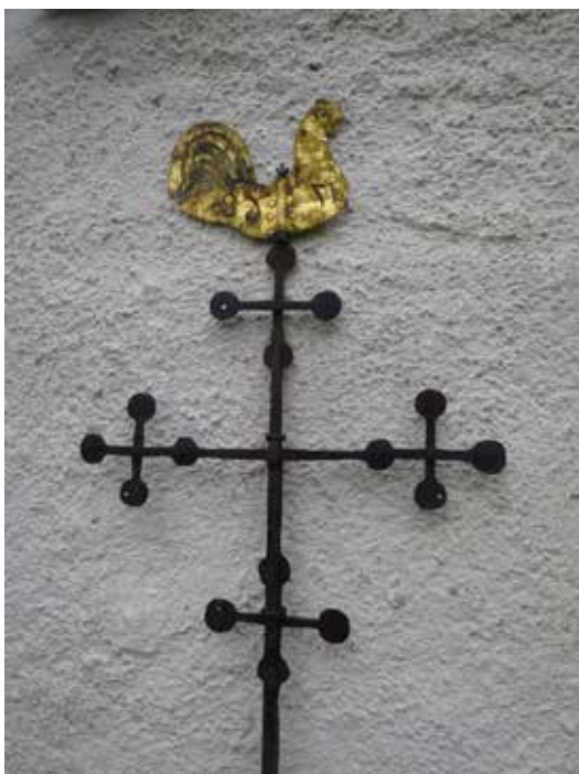
Takspiran på sakristinas tak togs ned för ommålning och förgyllning på verkstad.
