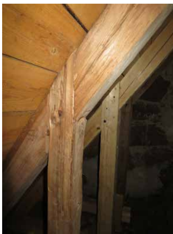
Lagning av nedre änden på stödbenet till takstol 2. Stödbenen gick ned på insidan av remstycket och på så sätt hindrade det takstolarnas nedre delar från att tryckas ut i sidled. Denna statiskt sett viktiga detalj bibehölls vid lagningen.
