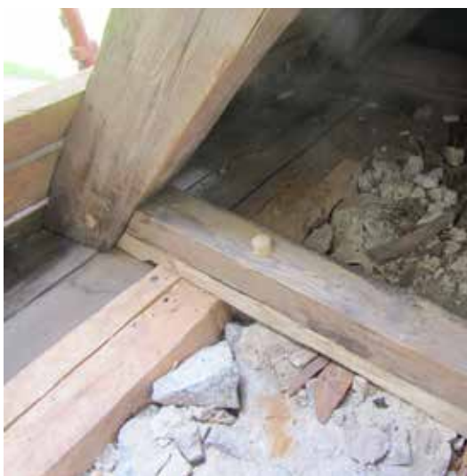
Det yttre remstycket ersattes i ett längre parti. För att det ålderdomliga remstycket skulle kunna behållas i sin utvändigt synliga del bibehölls en smal remsa av remstycket. En mindre halvsulning gjordes i ovansidan av denna del.
