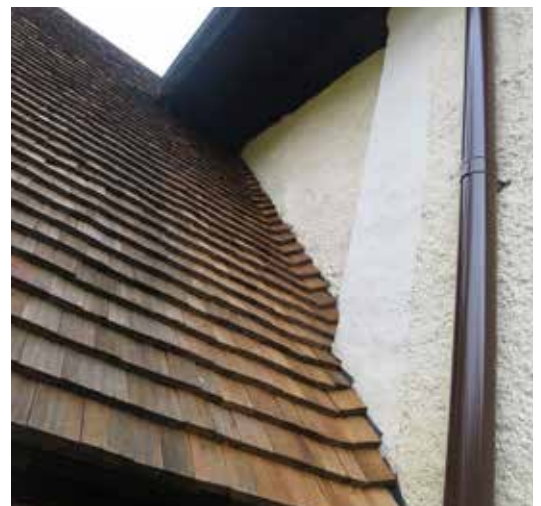
Spåntakens anslutningar mot långskeppets fasad utfördes lika tidigare med uppvikt spånnya mot fasaden. Den blev dock något mera vinklad och inte lika mjukt rundad som tidigare.
