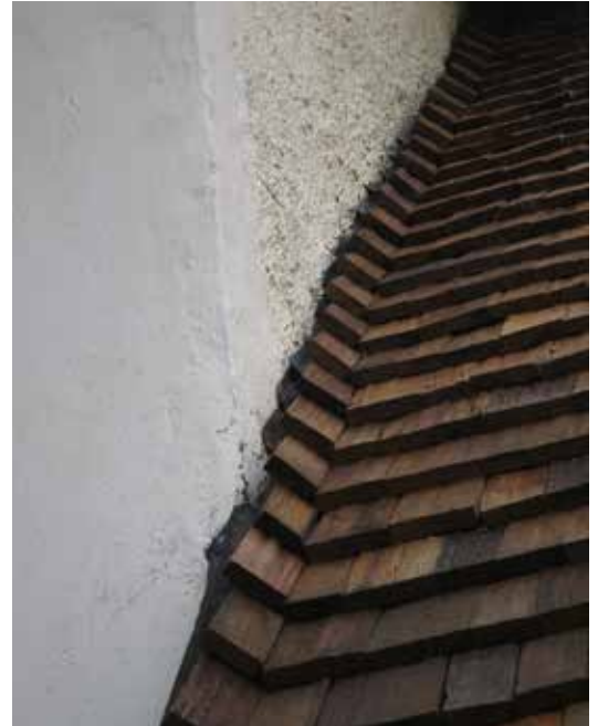
Spåntakens anslutningar mot långskeppets fasad utfördes lika tidigare med uppvikt spånnya mot fasaden. Den blev dock något mera vinklad och inte lika mjukt rundad som tidigare.
