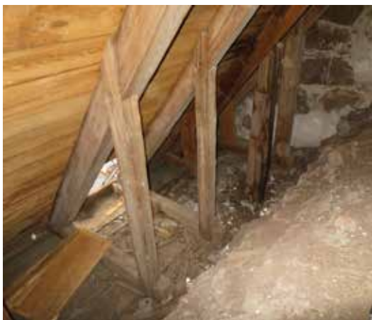
På murkrönens båda remstycken vilar takstolarna med sina knäbockar. Här syns en del av tunnvalvet samt takstolens östra upplag.
