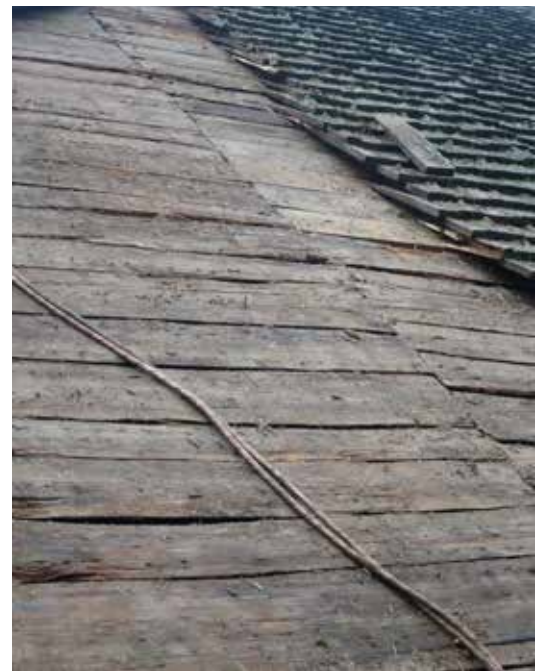
Taksvallen på långskeppets norra takfall var av ramsågade brädor och sannolikt lagd 1835.
