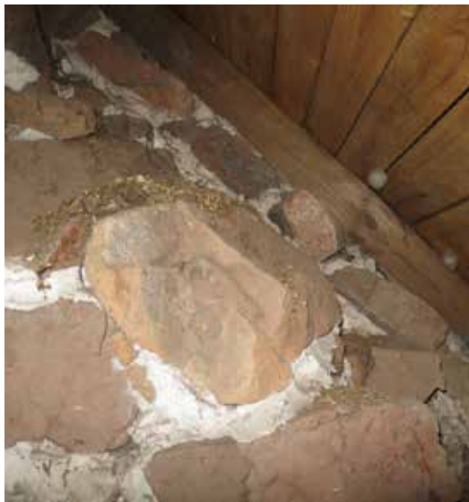
Del av sakristians norra gavel. Denna var sekundärt påbyggd, sannolikt för att passa den nuvarande takstolen. Till höger syns bevarade ålderdomliga träkrokar utmed långhusets norra remstycke.
