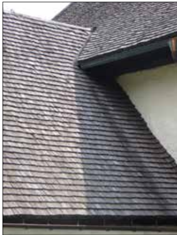
Närbild av de båda takens möte samt befintlig anslutning av spånen på sakristinas tak mot långhusfasad.
