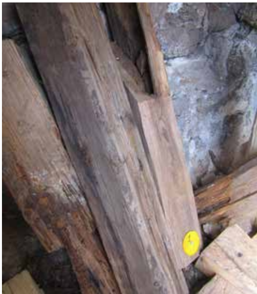
De delar av takstolarna som togs bort vid lagningen och som togs omhand och lades in på sakristians vind.
