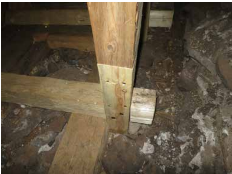
Lagning av nedre änden på stödbenet till takstol 2. Stödbenen gick ned på insidan av remstycket och på så sätt hindrade det takstolarnas nedre delar från att tryckas ut i sidled. Denna statiskt sett viktiga detalj bibehölls vid lagningen.
