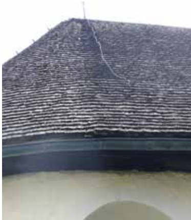
Närbild av övergång mellan korets och långskeppets norra tak. Korets tak var lagt med luftninglist i takfoten medan norra takfallet saknade sådan.
