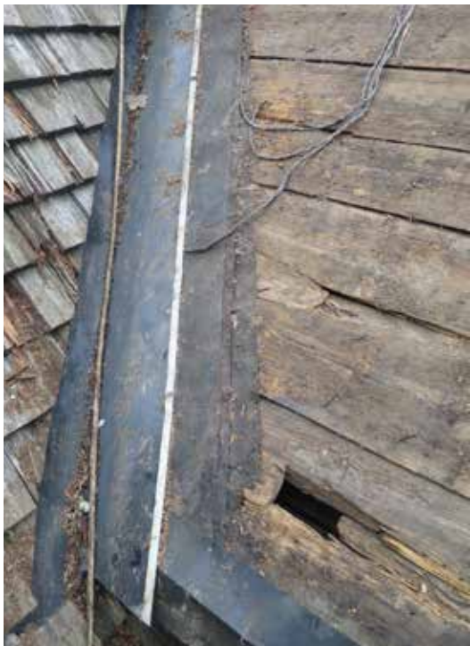
Den västra rännalen mellan sakristians och långskeppets norra takfall. I denna påträffades ett lager med tjärpapp, svartplåt därpå och överst dagens fabrikslackerade plåt. Notera även hålet i taksvallen som kan härröra från en äldre ställningsinfästning.
