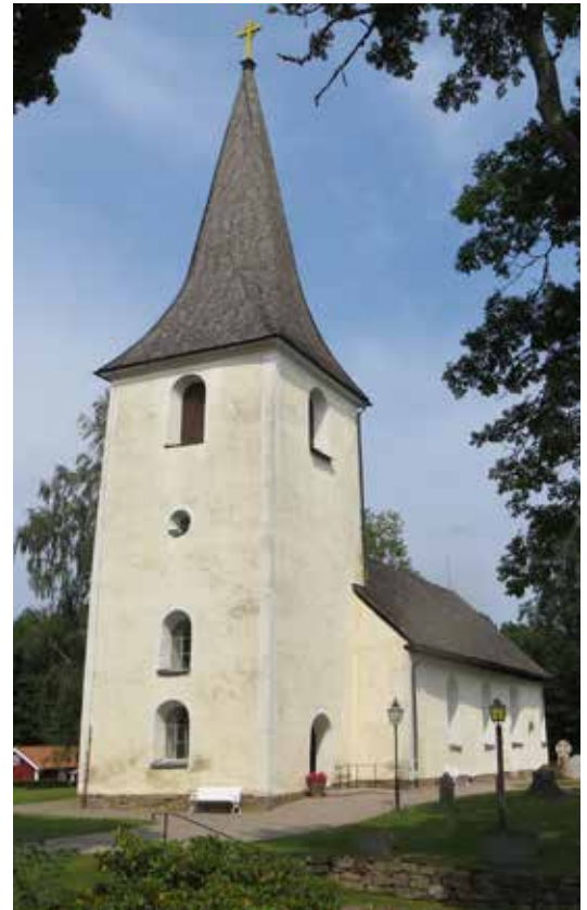
Nye kyrka före arbetenas uppstart i juli 2020.
