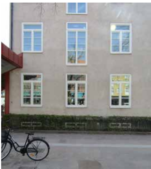
Hus A och dess förändrade fönstersättning och fönsterutformning efter en nyligen genomförd ombyggnad.
