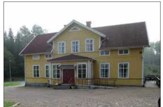
Södra Solberga kyrkskola har sedan 2008 genomgått en renovering där mycket i den ursprungliga exteriören förändrats.
