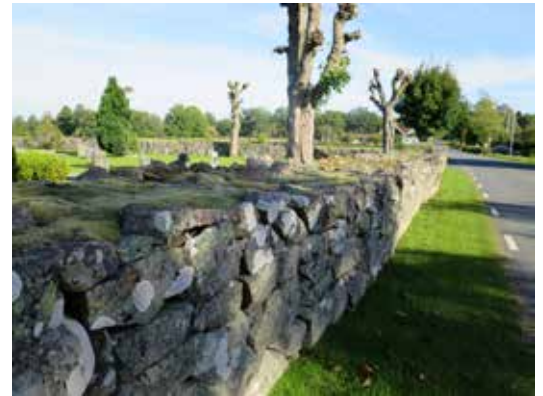
Den kraftiga kyrkogårdsmuren går sannolikt tillbaka till anläggningstiden 1851.
