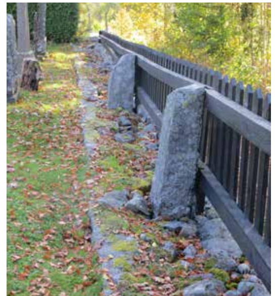
Kyrkogårdsmuren sedd från insidan med stenstöden och spjälstaketet.
