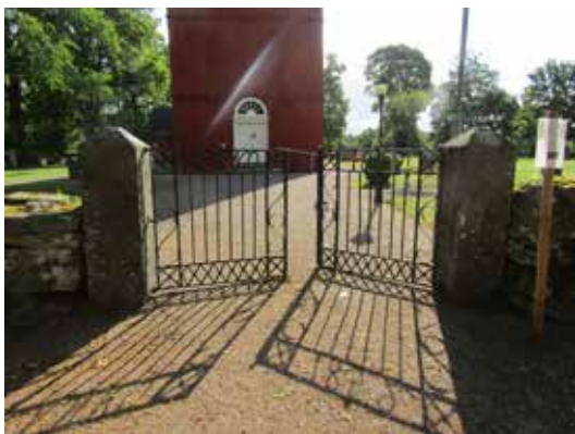
Gamla kyrkogårdens ingång via en smidd pargrind med årtalet 1852, upphängd på två kanthuggna granitstoplar med fasade krön från samma tid.
