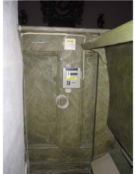
Ute- respektive inomhusgivare för styrning av värmen.
