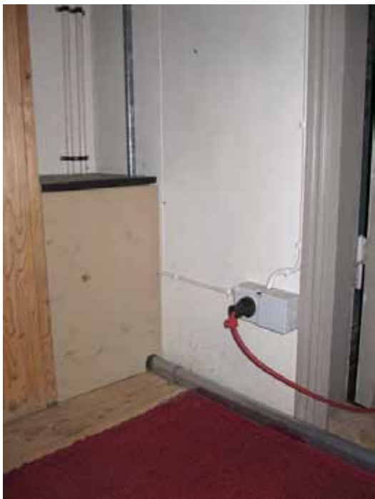
Ny kabelldragning inne i förrådet mot tröskeln, kabeln täcks av ett metallskydd.
