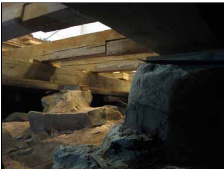
Utbyte av skadade bärlinor under korgolvet. På bilden till vänster syns de upplag av gråsten som man behövde säkra med murbruk.
