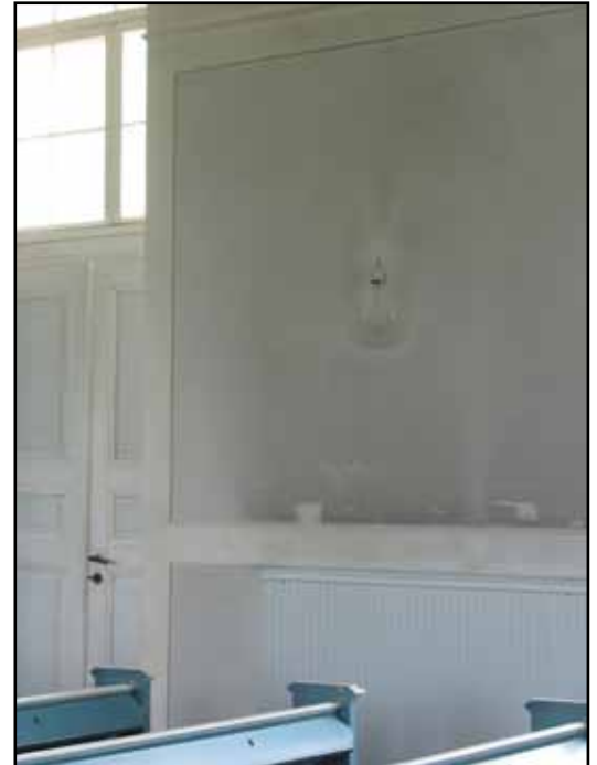
Heta radiatorer har bidragit till smutsningen av väggarna.
