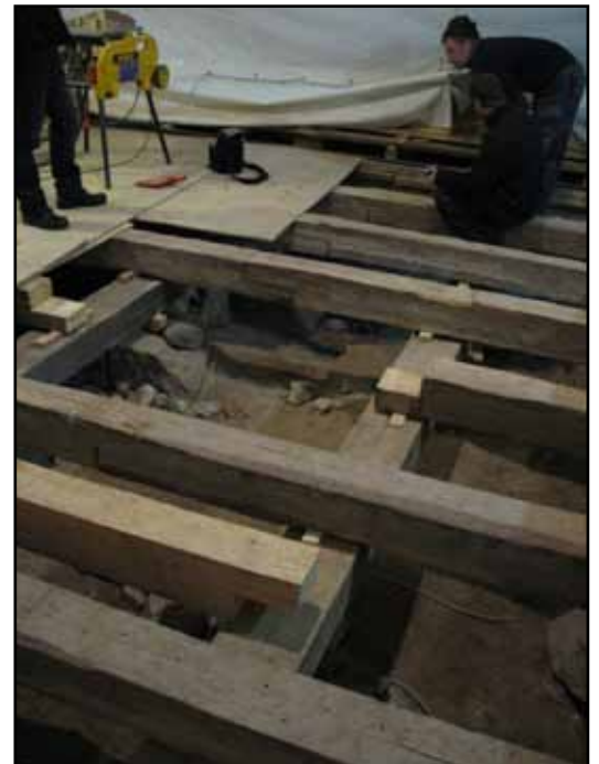
Utbyte av skadade bärlinor under korgolvet. På bilden till vänster syns de upplag av gråsten som man behövde säkra med murbruk.
