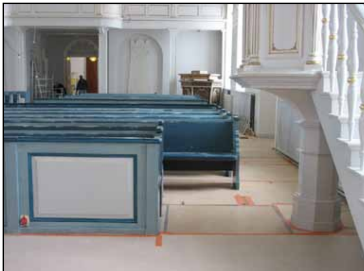
De främre två bänkarna mot koret på östra sidan kapades för att underlätta passage förbi predikstolen. Bänkskärmen kortades med en fyllning.
