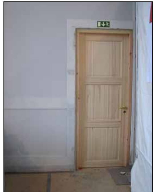
Ny halvfransk dörr i massiv furu in till sakristian.
