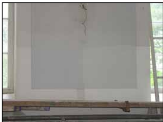
Provstrykningar av väggfält och listverk.
