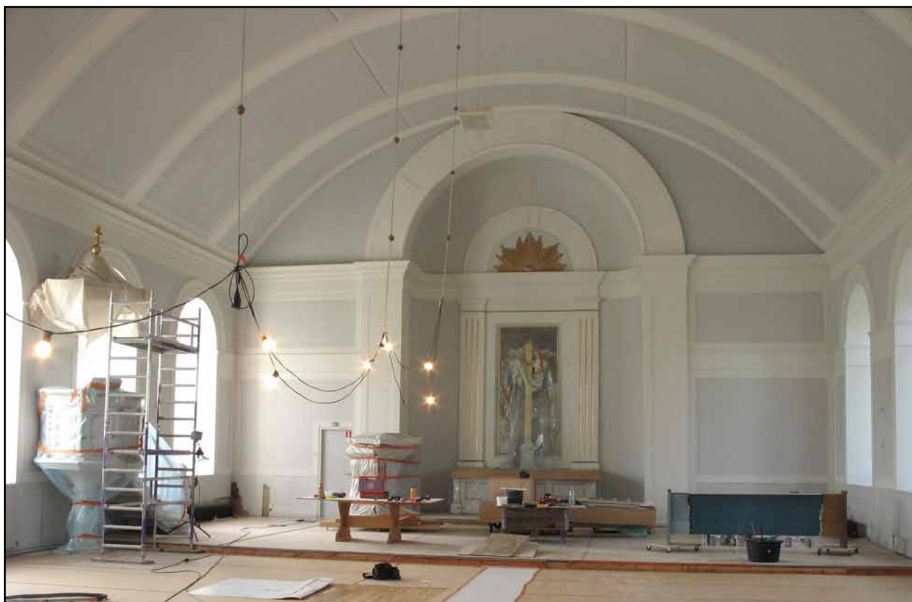
Kyrkorummet under pågående arbeten. Ommålning av väggar och valv färdigställd. Till höger i koret står en av bänkarna med två provmålningar, en i dalablått och en i brunt.
