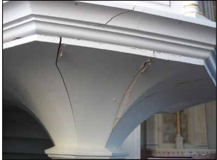
Torkrelaterade skador på predikstolskorgen.
