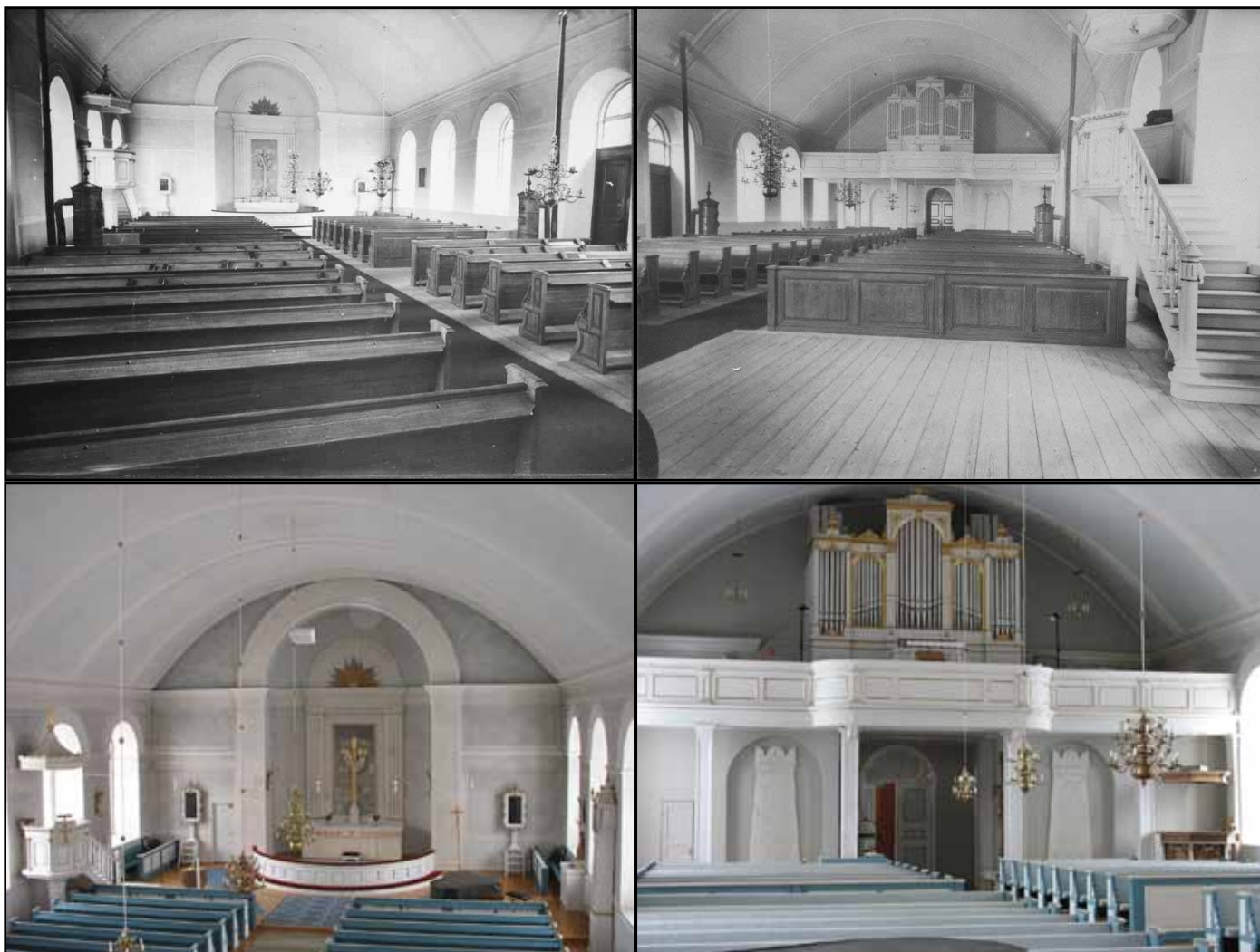
Överst kyrkorummet 1936 med bibehållen ursprunglig färgsättning med rent vitkalkade väggar och valv. Nedan dagens färgsättning från 1958 med kontrastverkan mellan olika nyanser av grått, något brutna åt grönt på väggarna och blått i taket.
