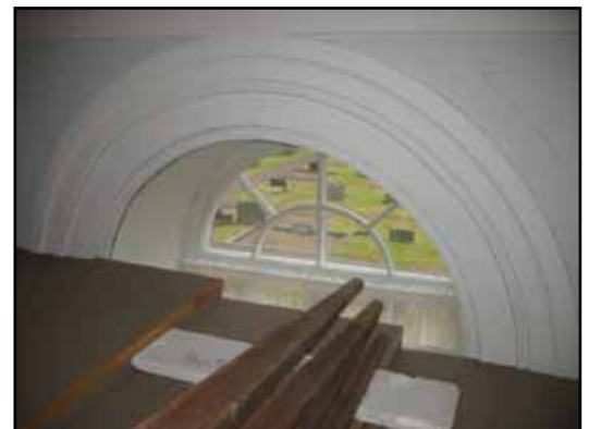
Nya gradänger i öster och en ljudavskärmande fönsterbåge mot den med samlingsrummet gemensamma smygen.
