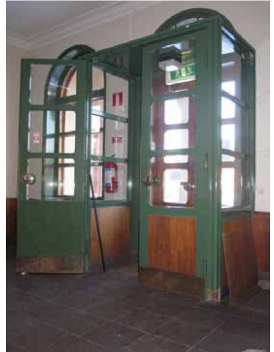
Vindfånget i vestibulen.
