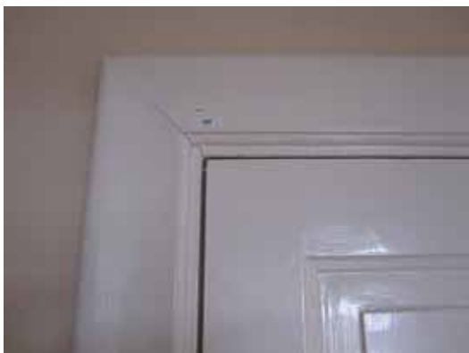
Tre generationer dörrfoder, äldst och ursprungligt, överst.
