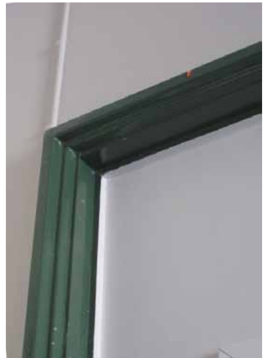
De höga dörrposterna i vestibulen och tingssalen har en lite speciell utformning genom sin konstruktion, formen tillkom troligen 1982.
