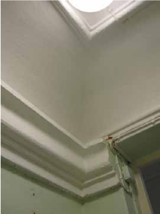
Takfris från den gamla tingssalen, nu inbyggd i toalett.
