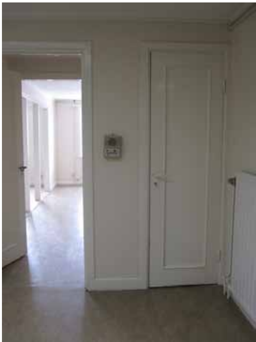
Övernattningsrummen på vinden gjordes om till lunch- och personalrum vid ombyggnaden 1982. Notera dörrbladets 40-talsutformning.
