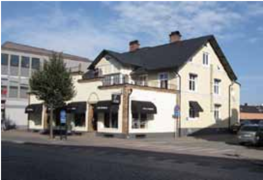
Boken 9 är ett av del äldre byggnaderna längs Storgatan. I bakgrunden skymtar Boken 10.
