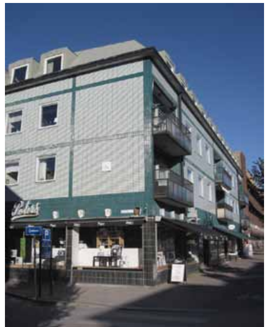
Lunden 11 har många tidstypiska detaljer från 1950-talet, så som fasadbeklädnaden av kakel och klinkers.
