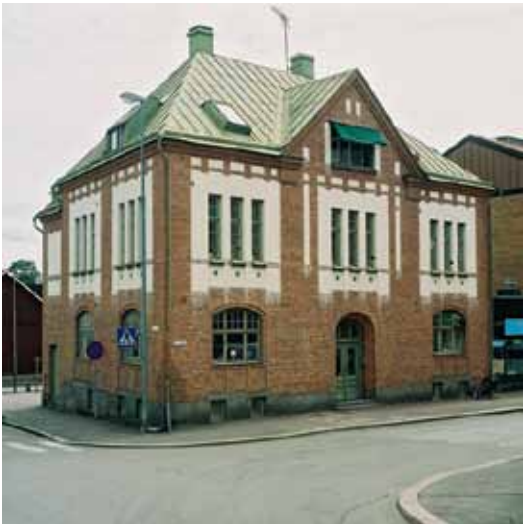
Det första stadshuset är väl bevarat från byggtiden. Tegelfasaden med de ljusa putsade partierna och dekorativt nyttjade kakelplattorna återkommer i flera av Atterströms byggnader från denna tid.
