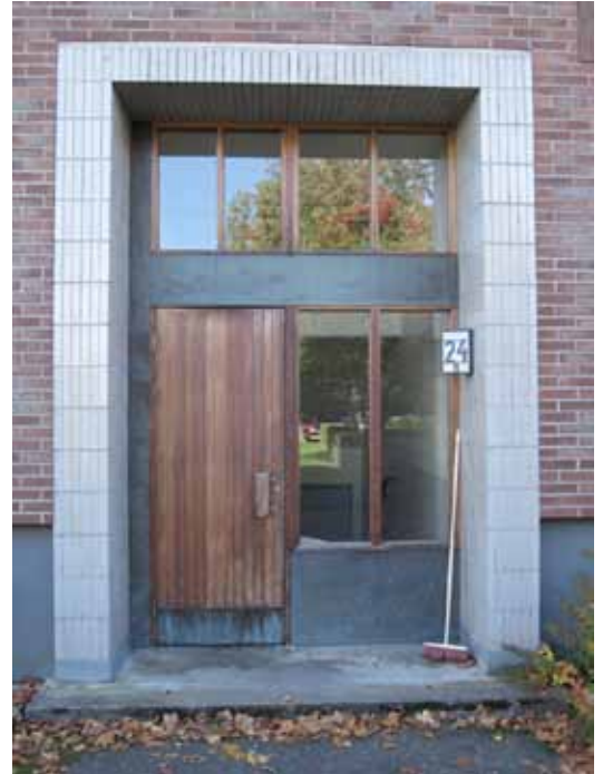
Leoparden 13 har bevarade originalportar och armaturer vid entrén.
