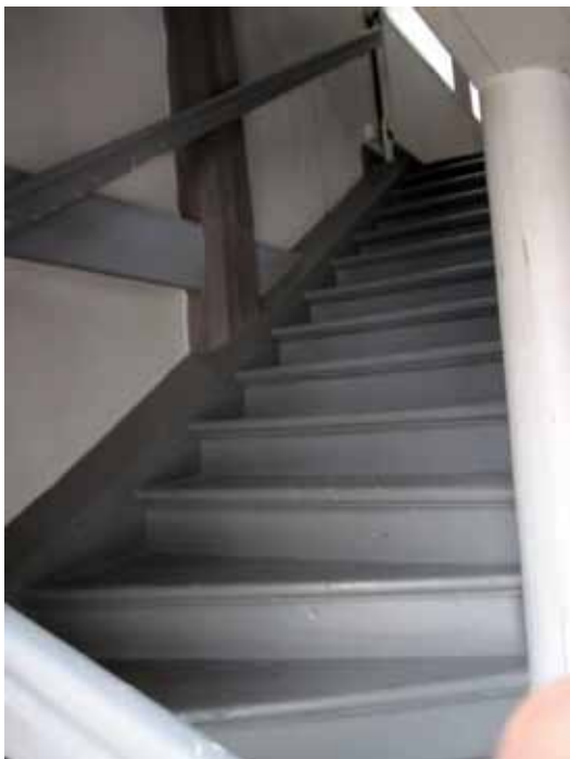
Trapploppet sett nedifrån inför arbetena.
