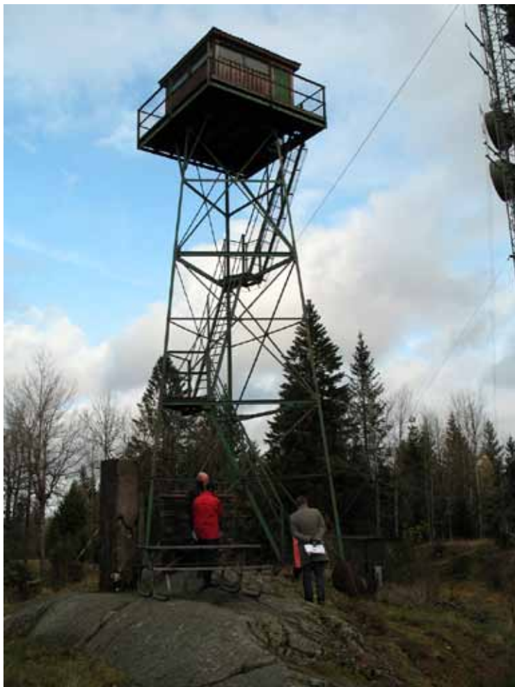
Luftbevakningstornet sett från marken innan restaureringen påbörjades.
