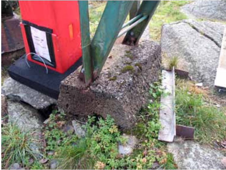
Trappans start utgörs av ett gjutet steg i betong.
