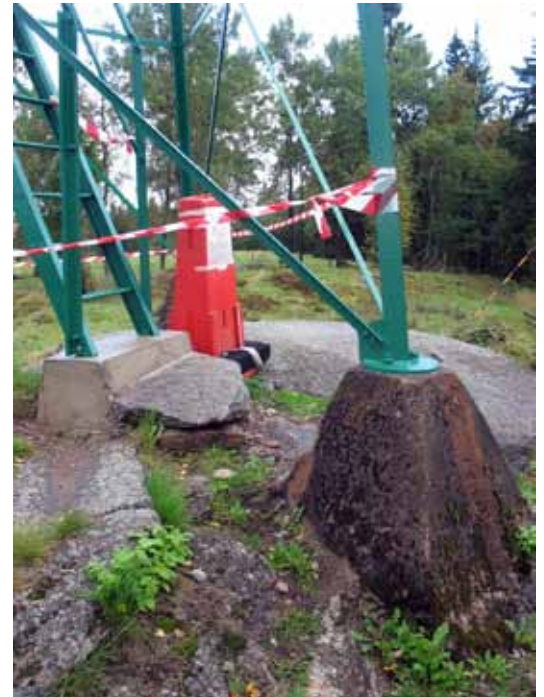
Till vänster syns det omgjutna fundamentet till uppstigningstrappan.
