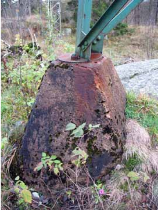
Betongplint inför restaureringen.
