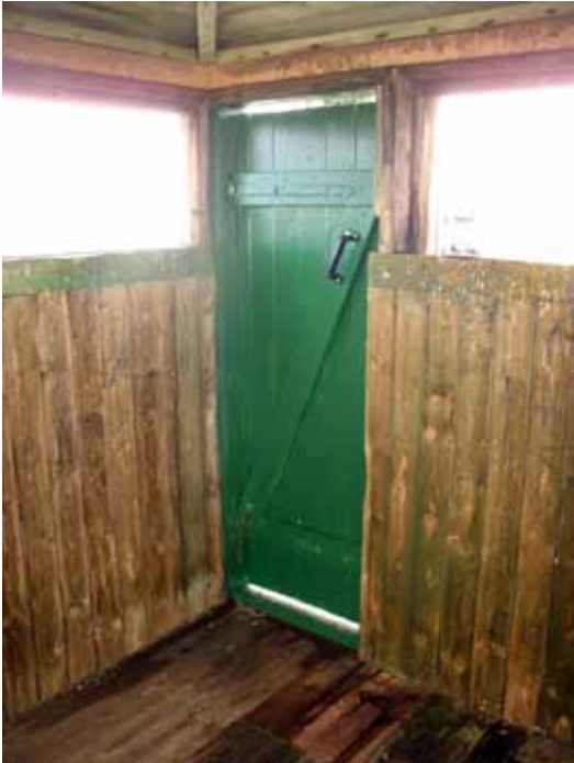
Plattformens insida med det nya dörrbladet, men innan återmontering av masonitskivan innanför dörren.
