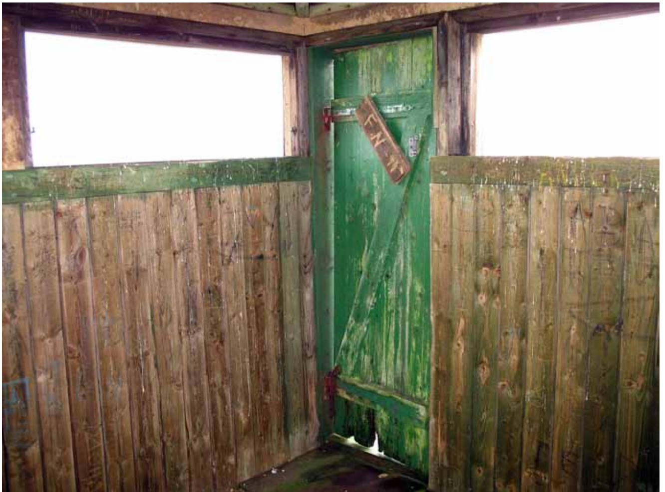
Inbyggnadens interiör inför arbetena.
