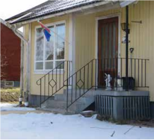
Enfamiljshus vid Ringvägen i Myresjö med ursprunglig ytterdörr och ursprungliga fönster med mönstrat glas.
