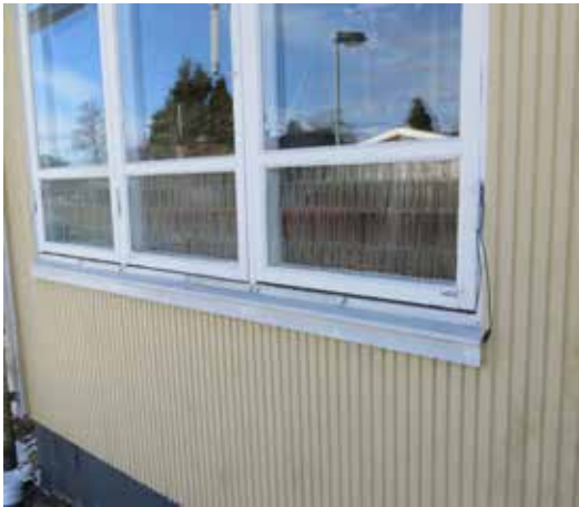
Detalj av fönsterparti med ovanlig spröjsindelning och mönstrat glas nedtill.
