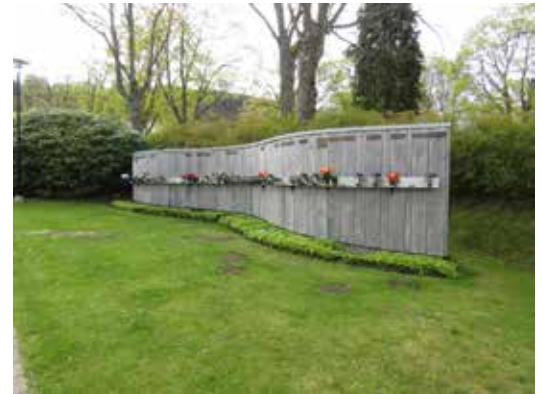
Askgravplatsen med en svängd mur klädd med plank.
