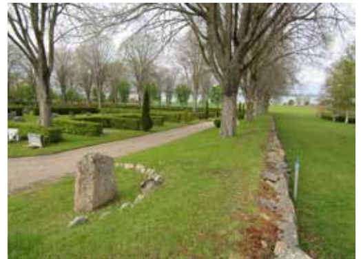
Mot norr och väster finns en kallmurad stödmur vilken är uppvallad från kyrkogårdssidan.
