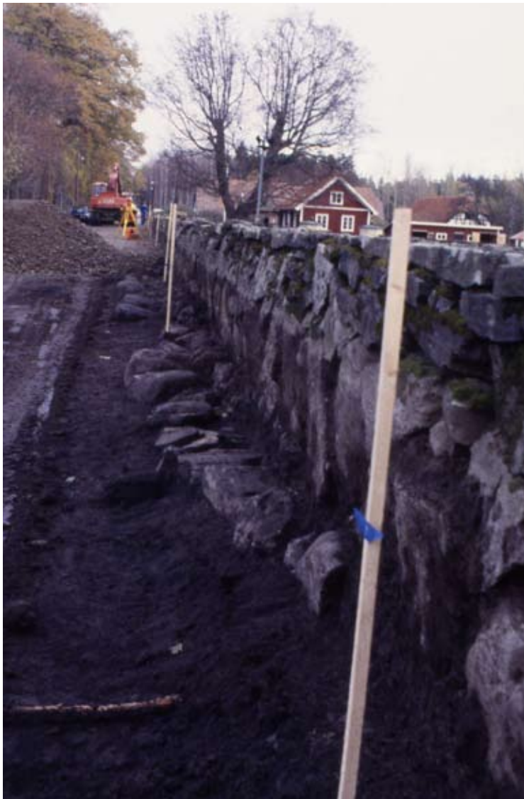
FIGUR 11 Muren som framkom vid sänkningen av vägen. Fotograferad från sydväst.
