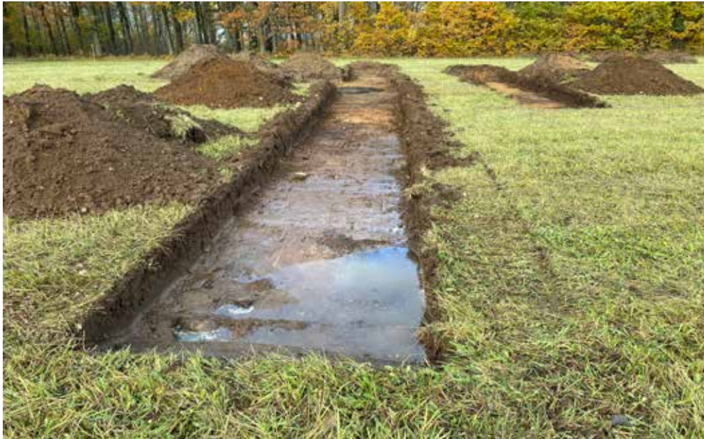
Figur 2. I områdets norra delar fylldes schakten snabbt upp med vatten som tryckte på underifrån.
