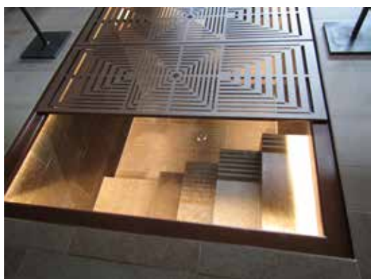
När dopgraven ska användas lyfts luckorna bort. Bassängens golv och sidor är klädda med Borghamnskalkssten.
