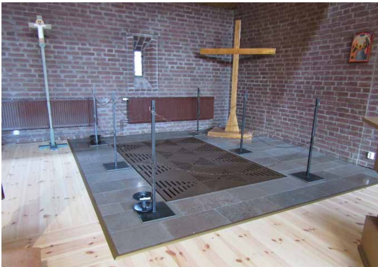
Den färdigställda dopgraven med det mobila räcket som ska kunna placeras ut när dopgraven används.
