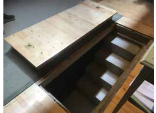
Dopgraven var övertäckt med löstagbara golvmoduler.
