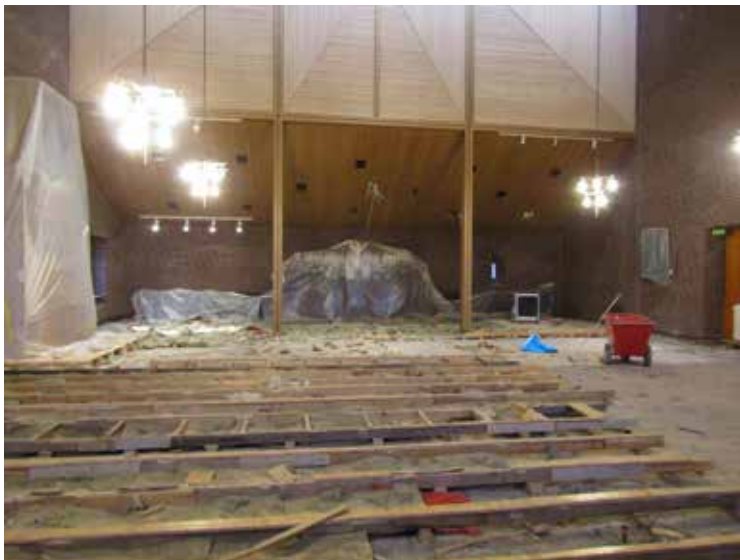
Den gamla underkonstruktionen bestod av träreglar som låg uppallade på brädbitar. Stenullsisoleringen låg direkt mot betongplattan. Nedan ses den nya s.k. nivellkonstruktionen med justerbara träreglar där isoleringen hänger på träreglarna.
