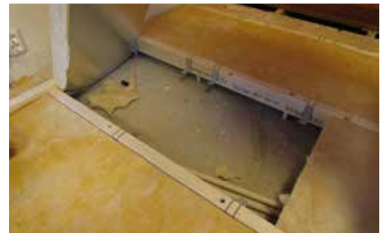
Den gamla underkonstruktionen bestod av träreglar som låg uppallade på brädbitar. Stenullsisoleringen låg direkt mot betongplattan. Nedan ses den nya s.k. nivellkonstruktionen med justerbara träreglar där isoleringen hänger på träreglarna.
