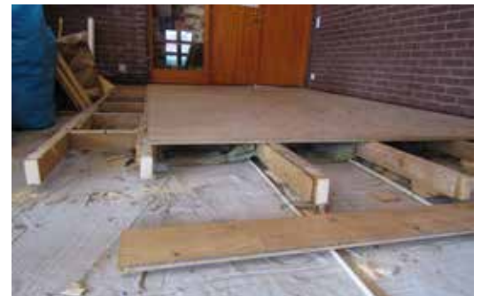
Den gamla underkonstruktionen bestod av träreglar som låg uppallade på brädbitar. Stenullsisoleringen låg direkt mot betongplattan. Nedan ses den nya s.k. nivellkonstruktionen med justerbara träreglar där isoleringen hänger på träreglarna.
