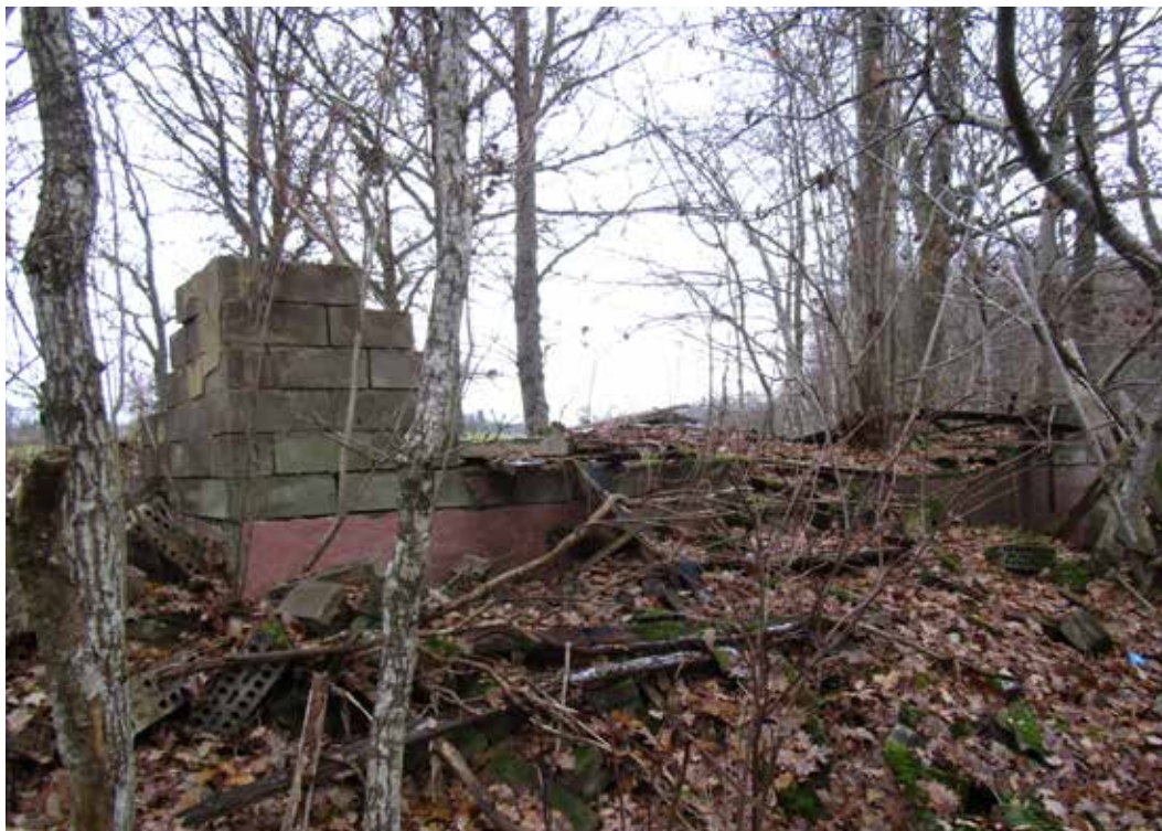
Figur 30. Kvarvarande byggnadsrester efter det fritidshus som legat på platsen.
