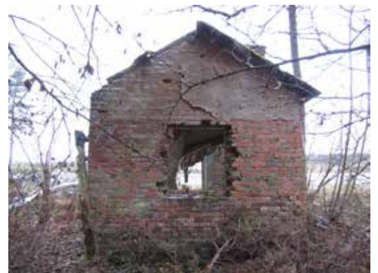
Figur 19. Östra gaveln har en sentida fönsteröppning.
