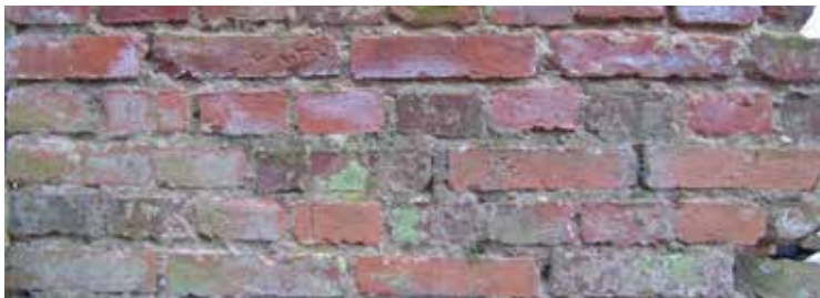
Figur 16. De tjocka tegelväggarna styrker att byggnaden kan ha uppförts som krutförråd.
