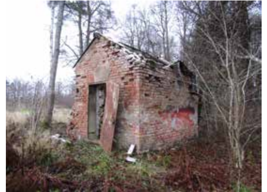
Figur 18. Tegelbyggnaden sedd från sydväst. Dörröppningen är försedd med en kraftig metaldörr.
