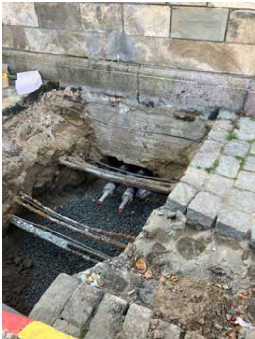
Grävningarna utanför och under trappans yttre mur. Dessa arbetena gjordes under arkeologisk schaktövervakning.
