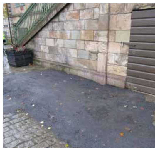
Ovan: Trottoaren tillfälligt täckt med asfalt. Till vänster: Installationerna i rum 003 och en skymt av rum 004.
