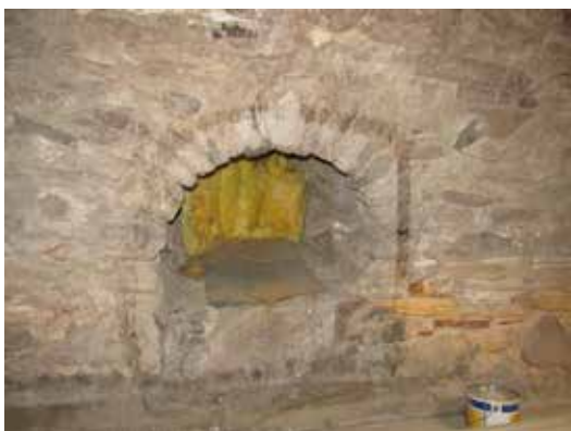
I en annan del av källaren finns ett bevarat valv för en ventil, att jämföra med ovanstående bild.
