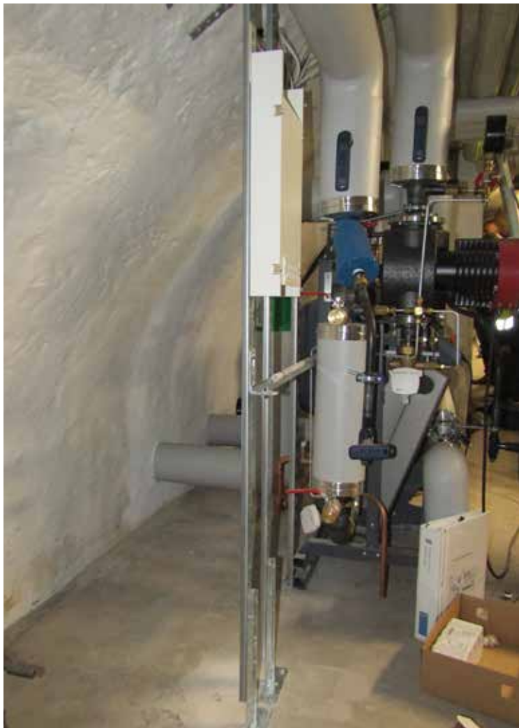
Monterad värmeteknik i rum 003 där inga ingrepp gjordes i stommen.
