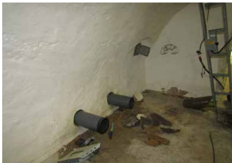
Ovan: Tre hål borrades från trappkällaren in till huvudkällaren.
