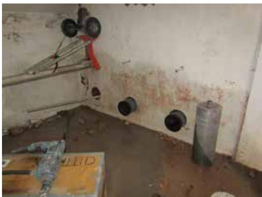
Ovan: Tre hål borrades från trappkällaren in till huvudkällaren.
