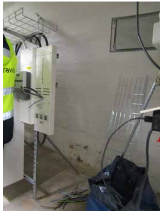
Monterad värmeteknik i rum 003 där inga ingrepp gjordes i stommen.
