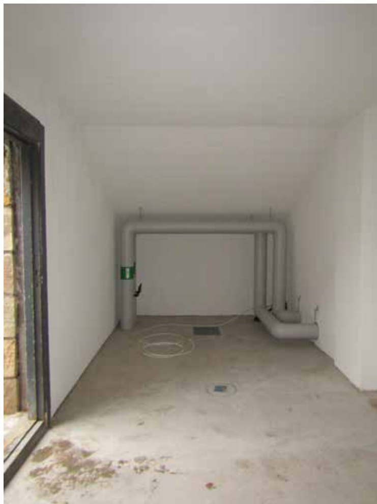
Källarutrymmet under den yttre trappan vid slutbesiktningen. En del mindre el-arbeten återstod.
