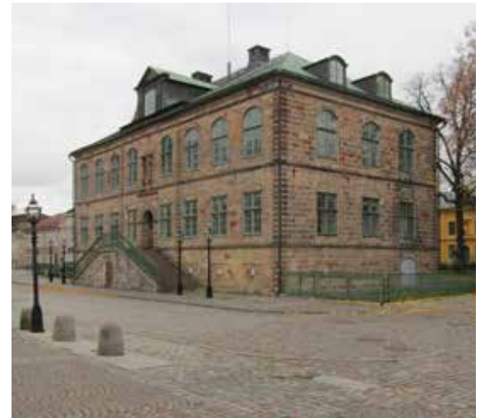
Göta hovrätts fasad mot norr 2021.
