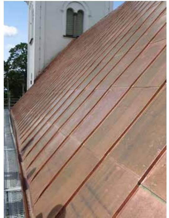
Det nylagda koppartaket på det södra takfallet.
