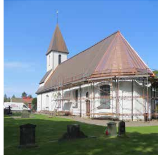
Forserums kyrkas tak erhöll kopparplåt som ersättning för ett tidigare spåntak 2016-17.
