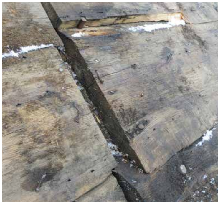
Detalj av takbottenbrädor där brädorna har snedskrädda kanter.
