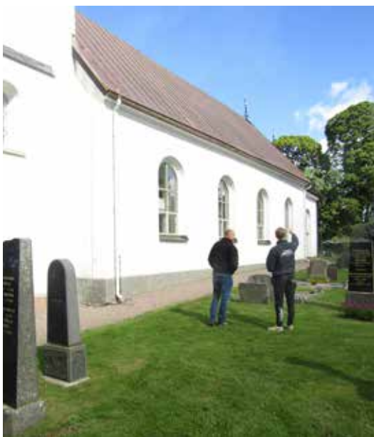
Det nya taket vid slutbesiktningen.
